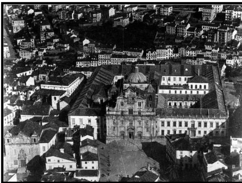
Fig. 39 - Pormenor da fachada de São João de Almedina e da Sé Nova localizada na Alta coimbrã 164 .
