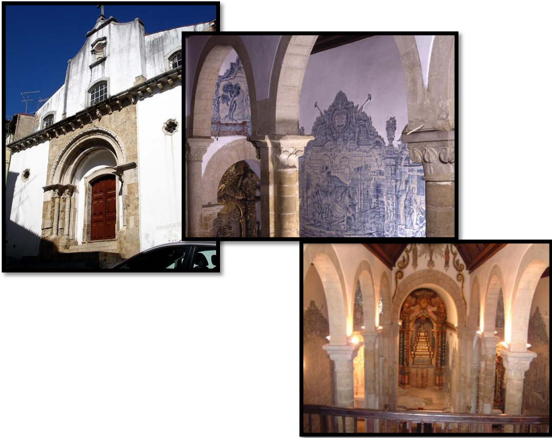
Fig. 20 - Fachada principal da Igreja de São Salvador, com respetiva nave central, capela-mor e lateral forrada a azulejos (fotografias da autora).
