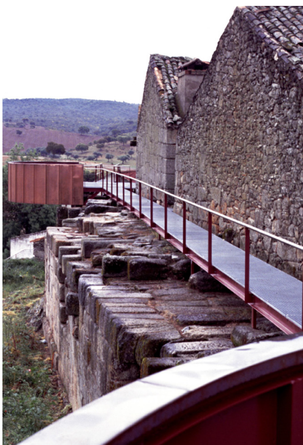
Fig. 8 | Intervenção na muralha romana de Idanha-a-Velha
