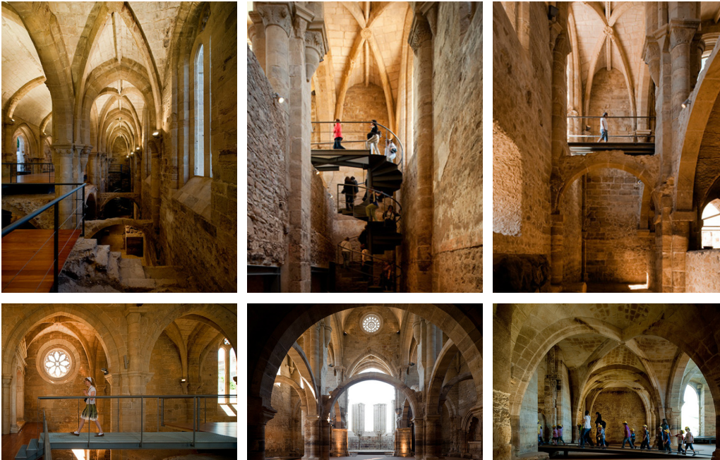
Fig. 60 | Ruínas do mosteiro e igreja após as intervenções Fig. 61, 62, 61, 63, 64, 65 | Interior da igreja após as intervenções
