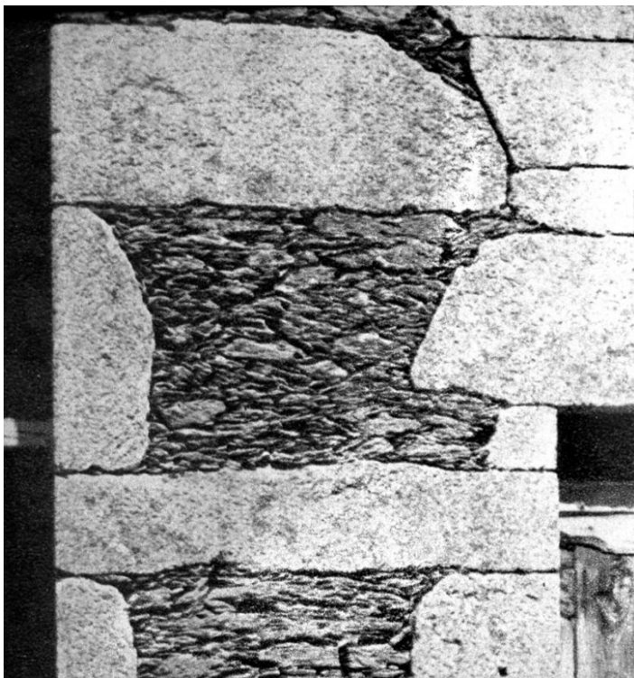
Fig. 1 | Textura de parede em alvenaria de cantaria
