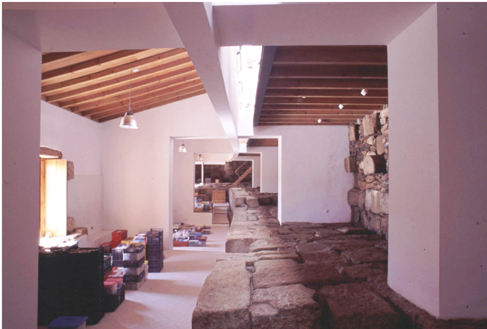
Fig. 49 | Fachada dos Palheiros de S. Dâmaso Fig. 50 | Interior dos Palheiros de S. Dâmaso
