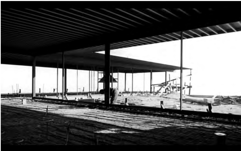
↓ Stahl House em construção na fase de início do de instalação do pavimento radiante.
