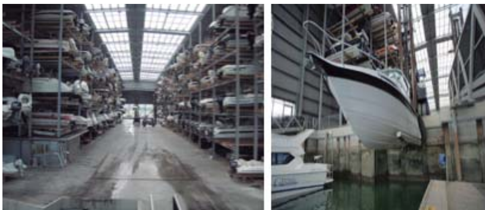
Figura 76. Serviço de armazenamento em terra de embarcações de recreio
