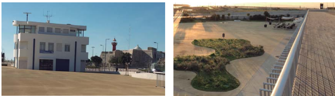
Figura 13. Área requalificada na zona poente adjacente à marina envolvendo a área da Administração do Porto e o Forte de Santa Catarina, e a área para atividades lúdico desportivas vista desde a cobertura do parque de estacionamento
