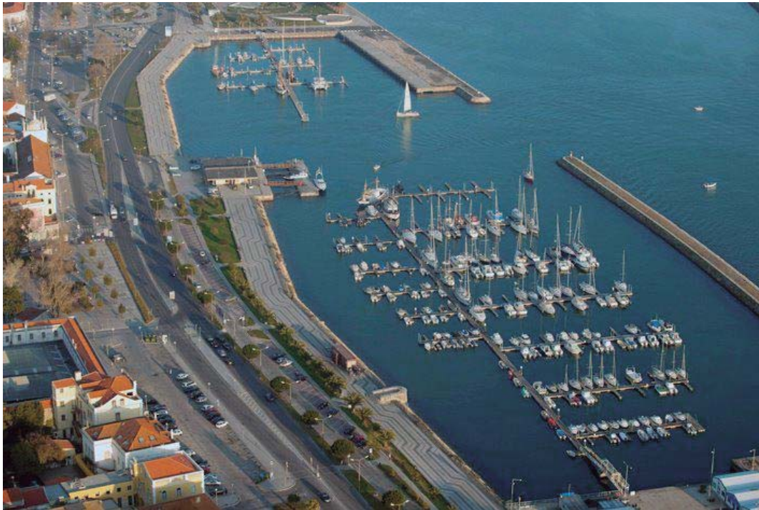
Figura 54. Vista aérea da marina no sentido poente - nascente
