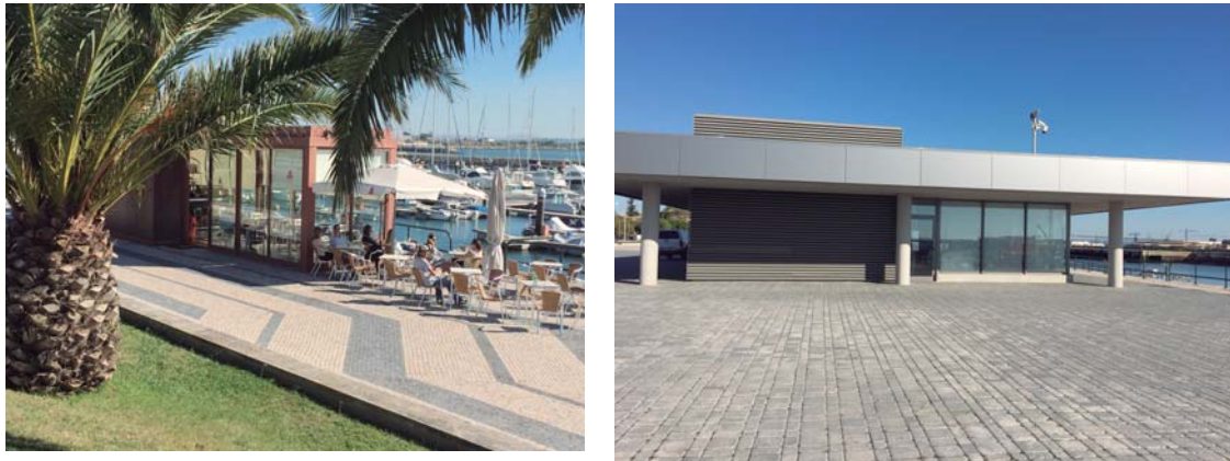
Figura 17. Café/bar e edifício da recepção da marina na via pedonal
