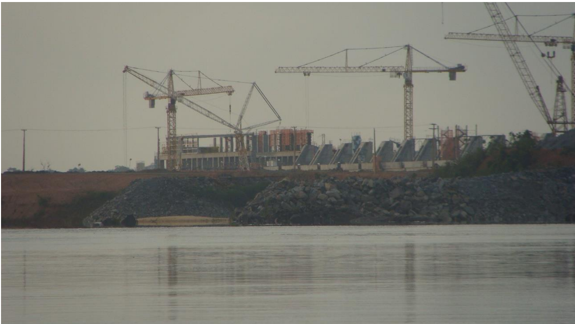
Figura 20: Obras da UHE Belo Monte. Fonte: Fotografia do autor
