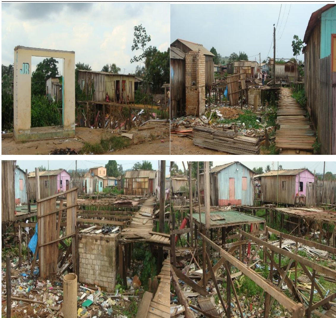
Figura 21: Algumas casas já destruídas após a desapropriação enquanto outras pessoas ainda não desapropriadas seguiam vivendo entre os escombros. Fonte: Fotografias do autor.
