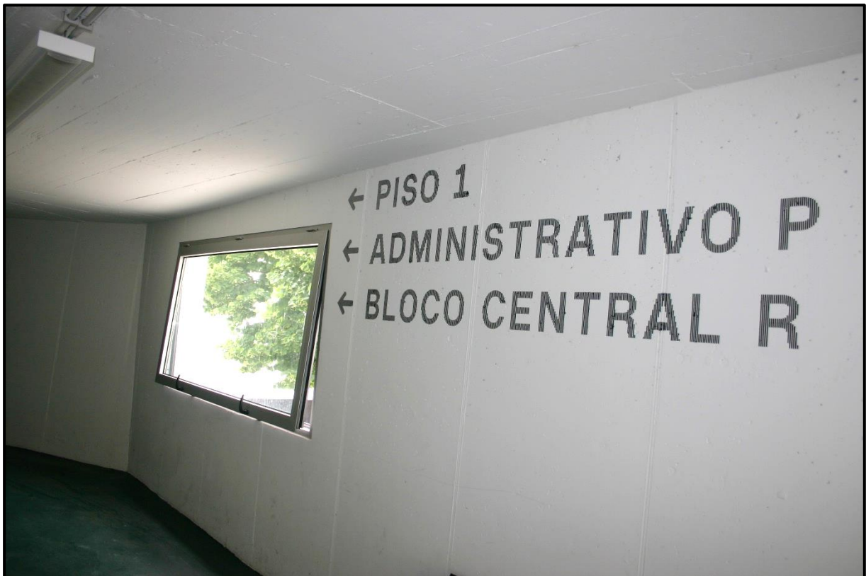
Figura 65- Mangas de acesso da Escola secundária Quinta das Flores em Coimbra Fonte: José Pedro Fernandes
