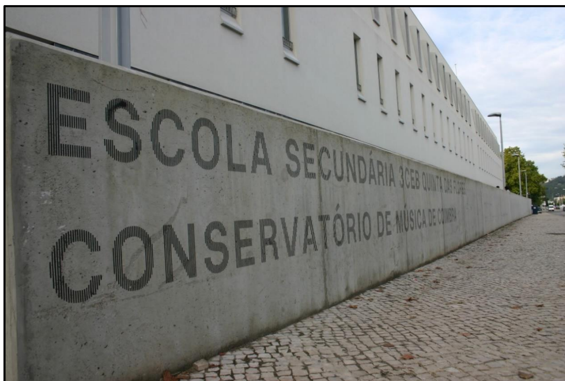
Figura 29- Aspeto do novo edifício que integra agora as duas instituições Fonte: José Pedro Fernandes
