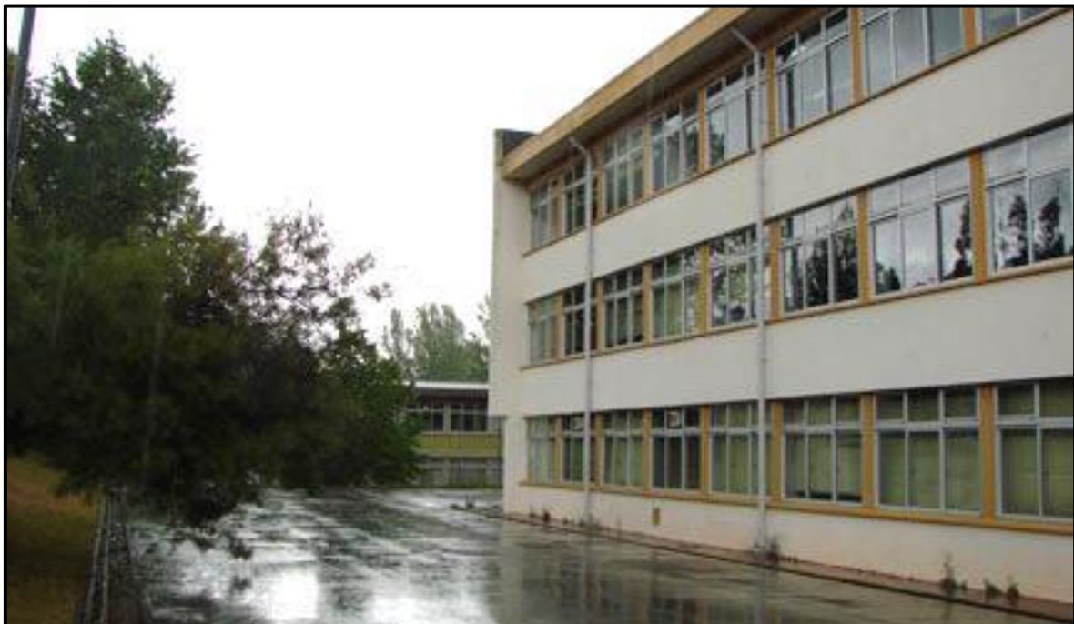
Figura 27- Aspeto dos pavilhões da antiga Escola Secundária Quinta das Flores Fonte: José Pedro Fernandes
