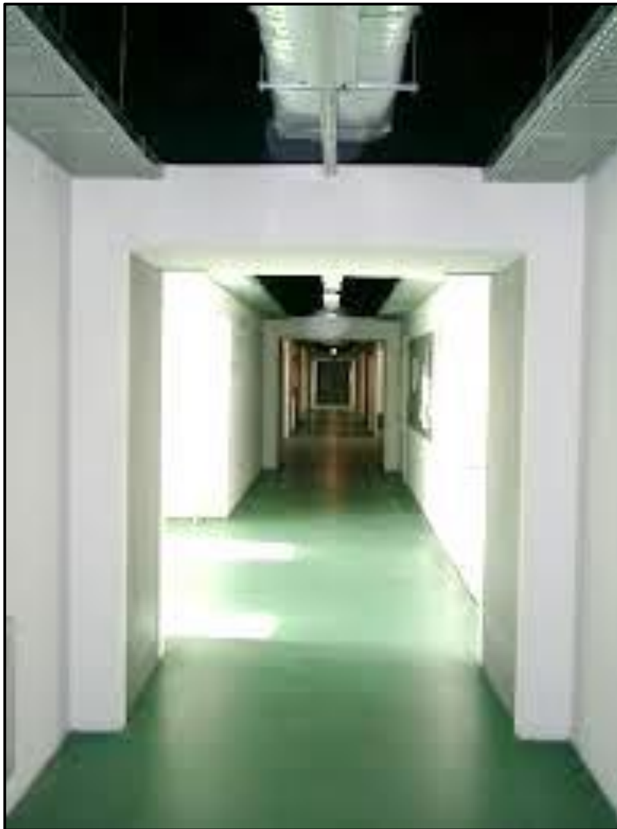
Figura 66- Corredores da Escola Secundária Quinta das Flores, em Coimbra Fonte: http://www.parque-escolar.pt/
