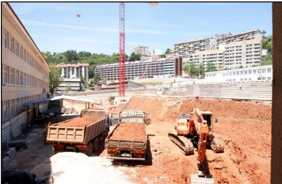
Figura 21- Obras do PMEES
