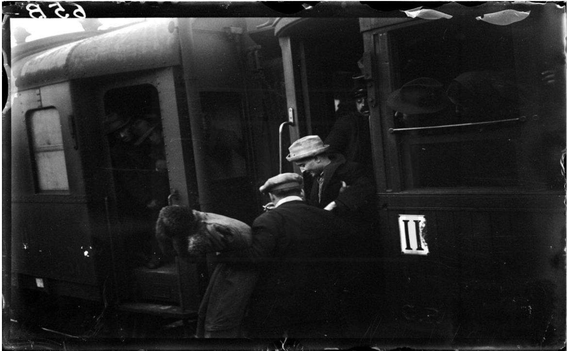
Figura 22 - José Júlio da Costa, acompanhado do seu captor, António Maria Fernandes, no cais da Estação de Entrecampos, à saída da carruagem, no dia 15 de janeiro de 1927. 1
