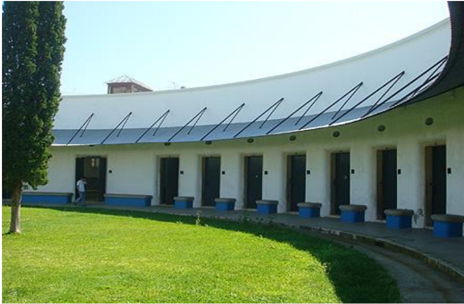
Figura 20: Interior do Pavilhão de Segurança 1 , para onde Aparício Rebelo dos Santos foi levado após o assassinato de Miguel Bombarda, em 1910 (fotografia recente).
