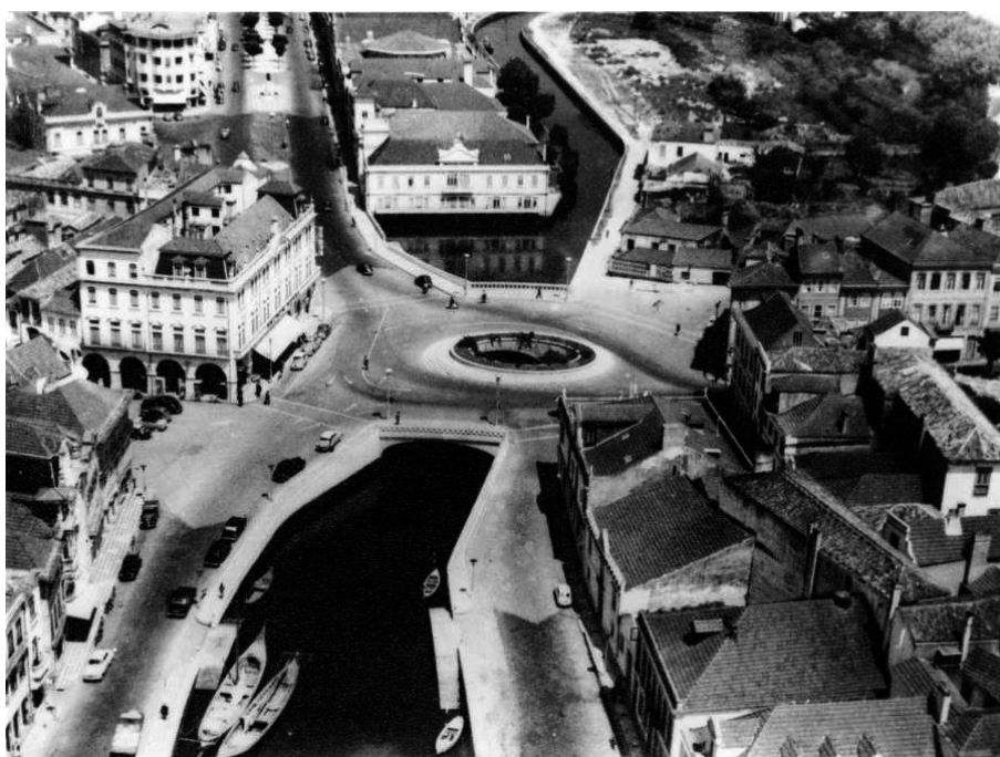
16 | Vista aérea sobre a zona central e Ponte-Praça| Década de 60
