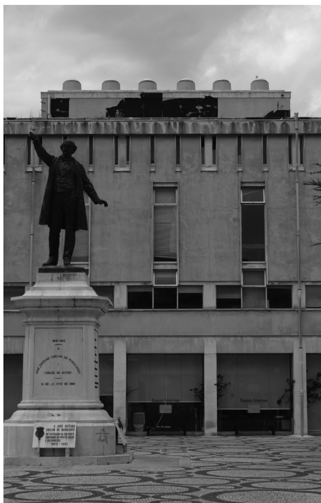
60 | Pormenor da Fachada Sul (Virada para Praça da República) | Edifício Municipal | 2015
