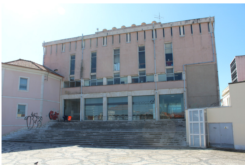
52 | Edifício Municipal | Vista sobre fachada Sul | 2015
