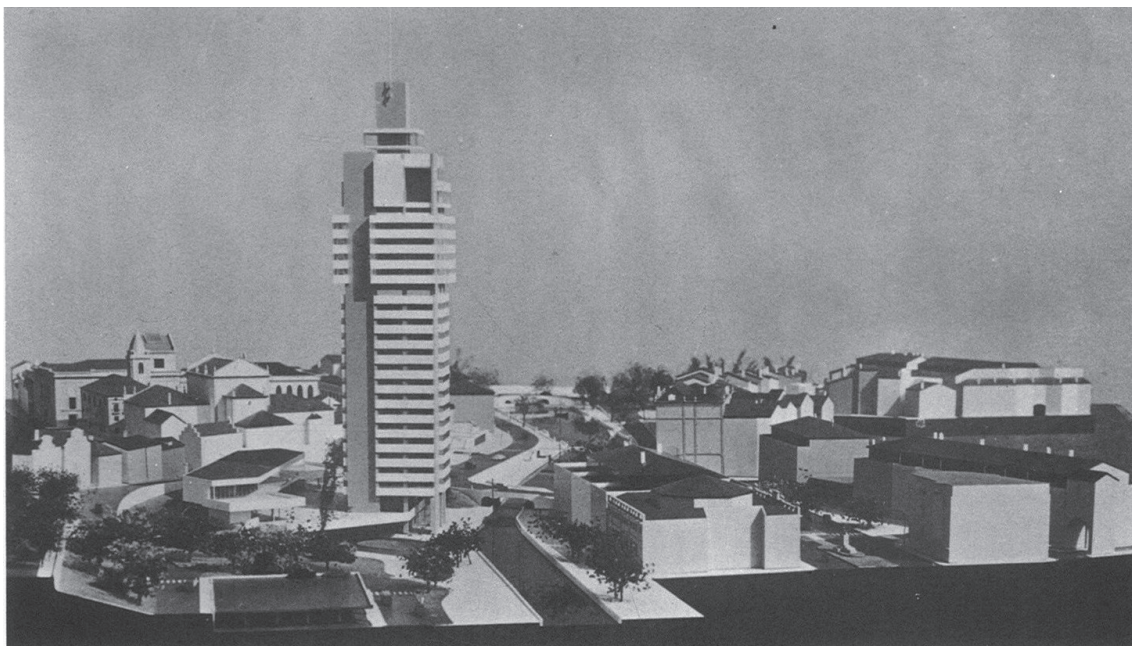
37 | Planta da proposta | Localização da Torre e Centro Comercial | Arranjo da Zona Central de Aveiro | 1964
