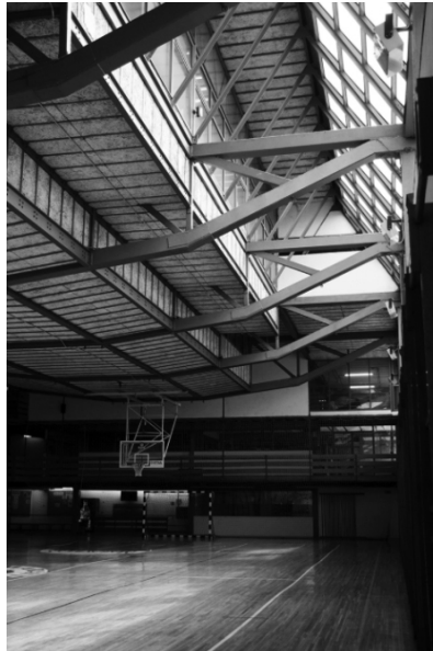
13. Vista do Interior do Ginásio do Colegio Maravillas
