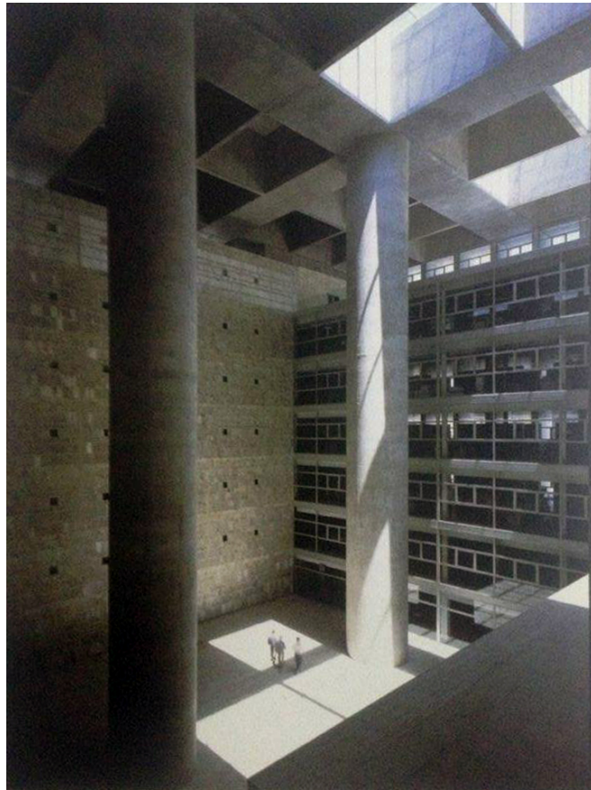
55. Vista da luz no interior da Caja General de Granada
