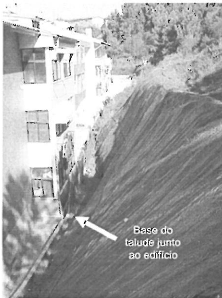
Figura 3 Vista do talude de escavação, junto ao perfil AA' (zona 1), que se encontra protegido com um geotêxtil.
