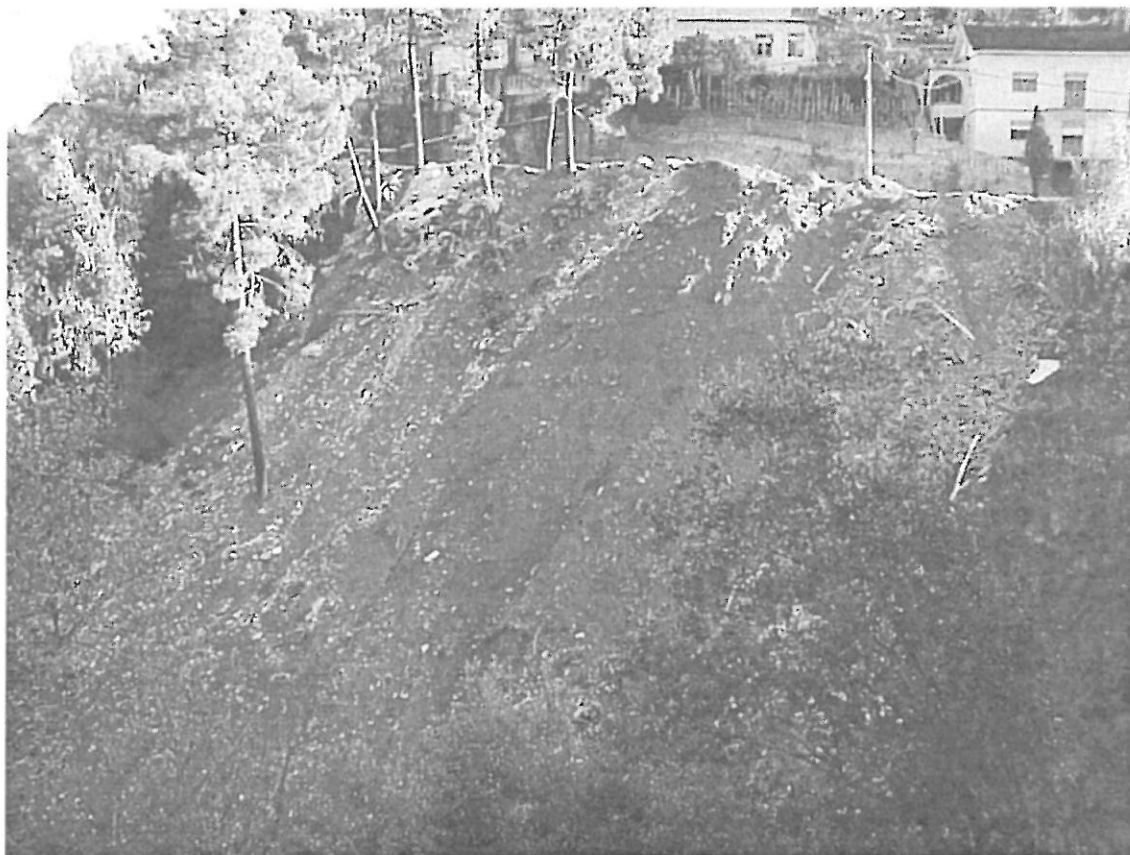
Figura 18 Depósitos de restos de construções em talude nas Carvalhosas.
