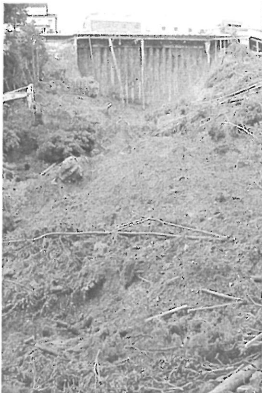
Figura 12 Vista geral da instabilização da Av. Elísio de Moura, tendo ficado visíveis as estacas moldadas executadas através do aterro em 1998 e que sustentaram os terrenos nos logradouros das vivendas.
