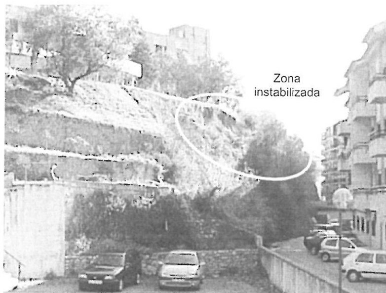
Figura 7 Vista do talude entre a Rua Miguel Torga e a CCRC.
