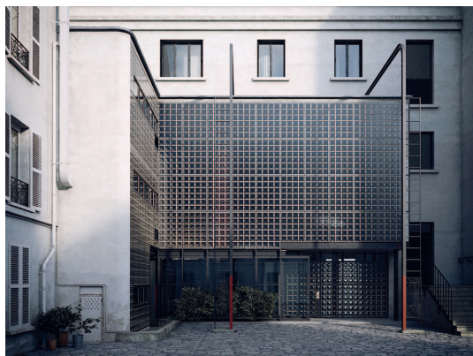
↑ Vista da fachada principal da Casa de Vidro.
