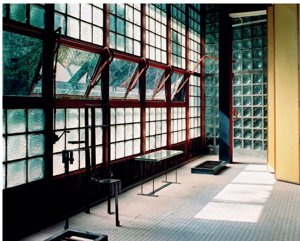
↑ Zona de espera do consultório do Dr. Dalsace com pormenor do sistema de abertura de vãos.
