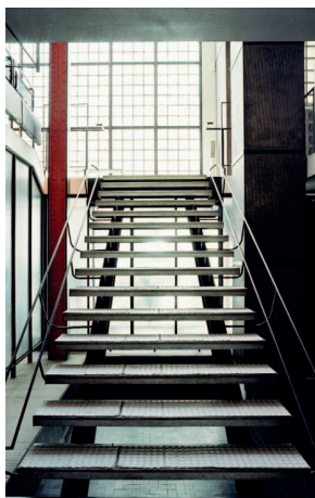
↑ Escada principal onde é visível a utilização de aço em inúmeras partes da casa.
