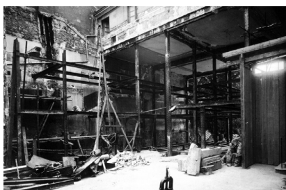
Foto durante os trabalhos de demolição com estrutura de suporte.
