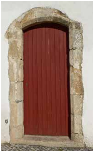
Fig. 139 - Porta no muro norte do pátio de recebimento (2012, fotografia da autora)
