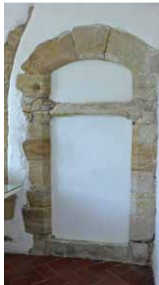
Fig. 152 - Porta emparedada no gabinete sul do piso térreo, vista do interior (2012, fotografia da autora)
