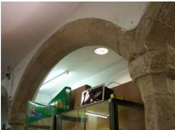
Fig. 91 - Arcos do claustro do Antigo Hospital Real de Coimbra (2013, fotografia de Miguel Furtado)
