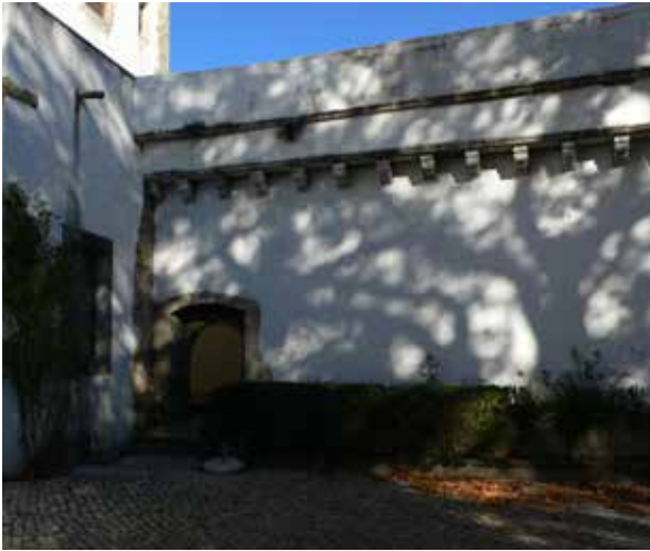
Fig. 173 - Muro e passadiço de ligação do paço à capela (2012, fotografia da autora)
