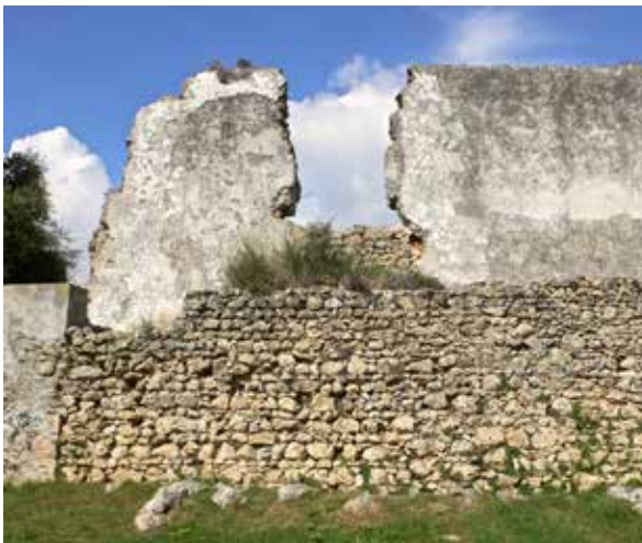
Fig. 50 - Parede do corredor exterior (2012, fotografia da autora)
