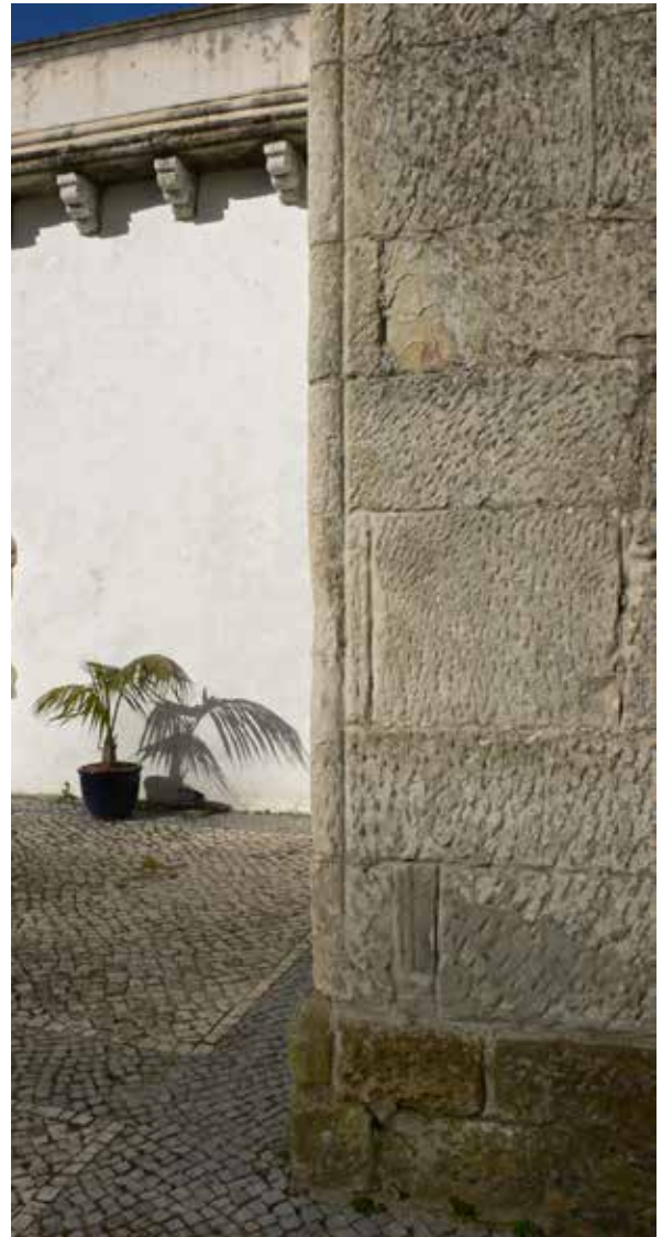
Fig. 143 - Colunelo da aresta do alpendre de entrada do paço (2013, fotografia da autora)
