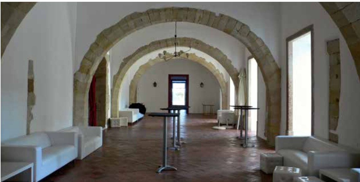
Fig. 89 - Arcos chanfrados da Sala Grande (2012, fotografia da autora)
