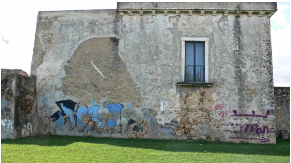
Fig. 3 - Torre nascente (2012, fotografia da autora)
