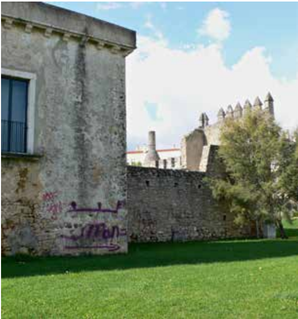
Fig. 4 - Torre nascente e torre nordeste (2012, fotografia da autora)
