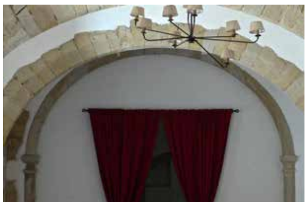
Fig. 198 - Arco de volta perfeita na parede sul da Sala Grande (2012, fotografia da autora)
