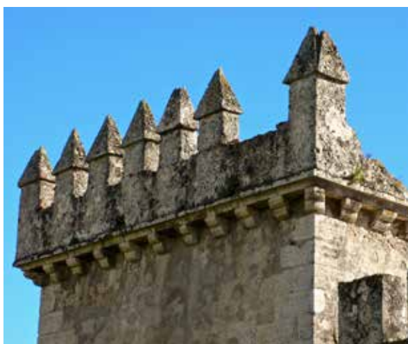
Fig. 38 - Merlões da torre nordeste (2012, fotografia da autora)
