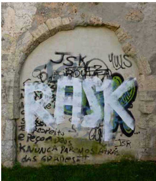
Fig. 10 - Porta entaipada na fachada norte da torre nascente (2012, fotografia da autora)
