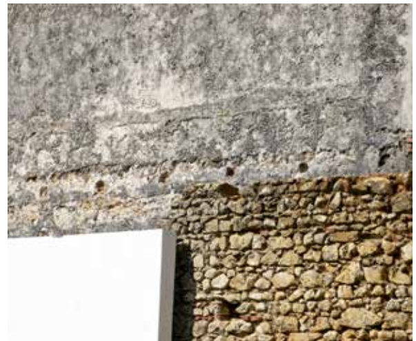
Fig. 51 - Orifícios da cobertura do corredor exterior (2012, fotografia da autora)
