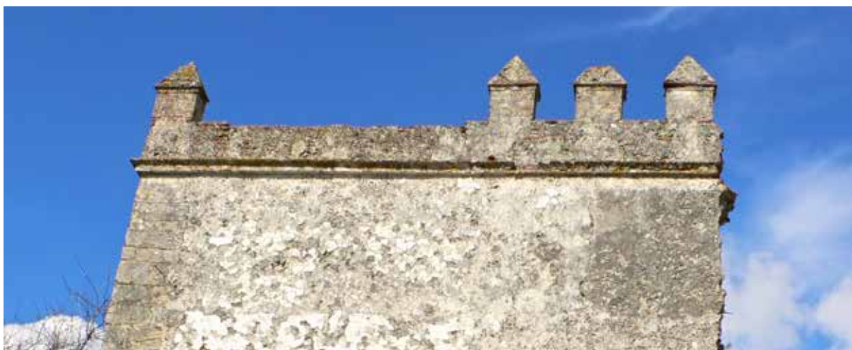
Fig. 37 - Merlões da torre sudoeste (2012, fotografia da autora)
