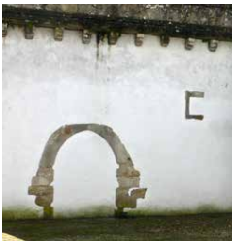
Fig. 199 - Vestígio de uma janela rectangular (2013, fotografia da autora)
