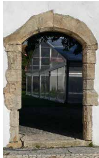
Fig. 140 - Porta no muro norte do pátio de recebimento (2012, fotografia da autora)
