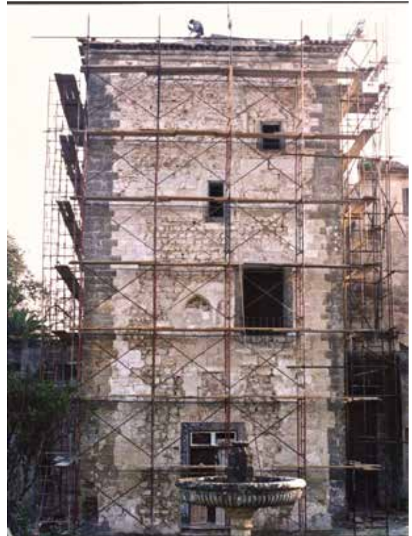
Fig. 63 - Alçado norte da torre medieval durante os trabalhos renovação (1992; fonte: Sagrial)
