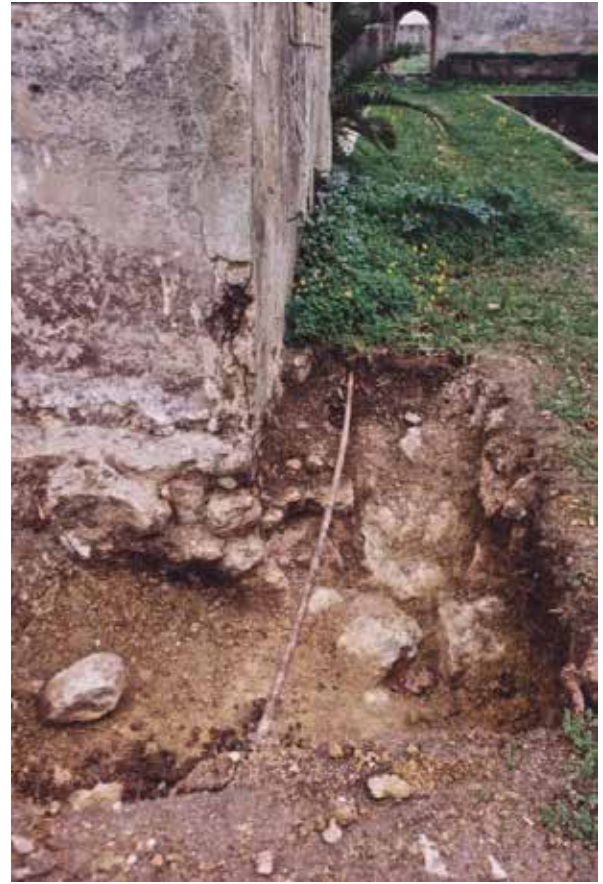
Fig. 76 - Vestígios de fundações junto da fachada nascente do paço (fotografia cedida pelo arquiteto João Rito Afonso)
