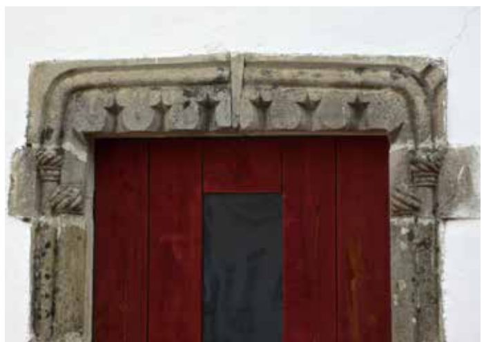
Fig. 168 - Detalhe da mesma porta (2012, fotografia da autora)
