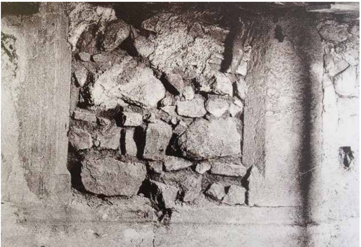
Fig. 8 - Vão de porta descoberto durante as obras na Sala dos Capelos da Universidade de Coimbra (fonte: António Filipe Pimentel, A Morada da Sabedoria , p. 296)
