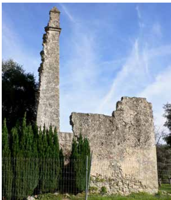
Fig. 52 - Ruínas do baluarte Sudoeste (2012, fotografia da autora)
