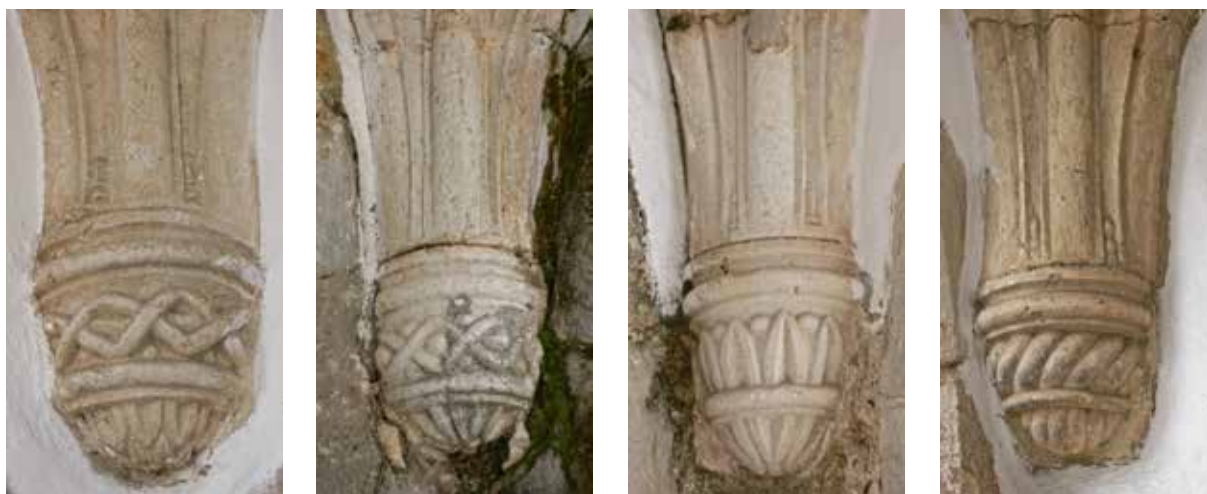
Fig. 145 - Mísulas da abóbada do alpendre de entrada do paço (2012, fotografia da autora)
