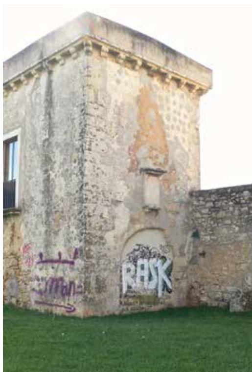
Fig. 9 - Aspeto da fachada norte da torre nascente (2012, fotografia da autora)
