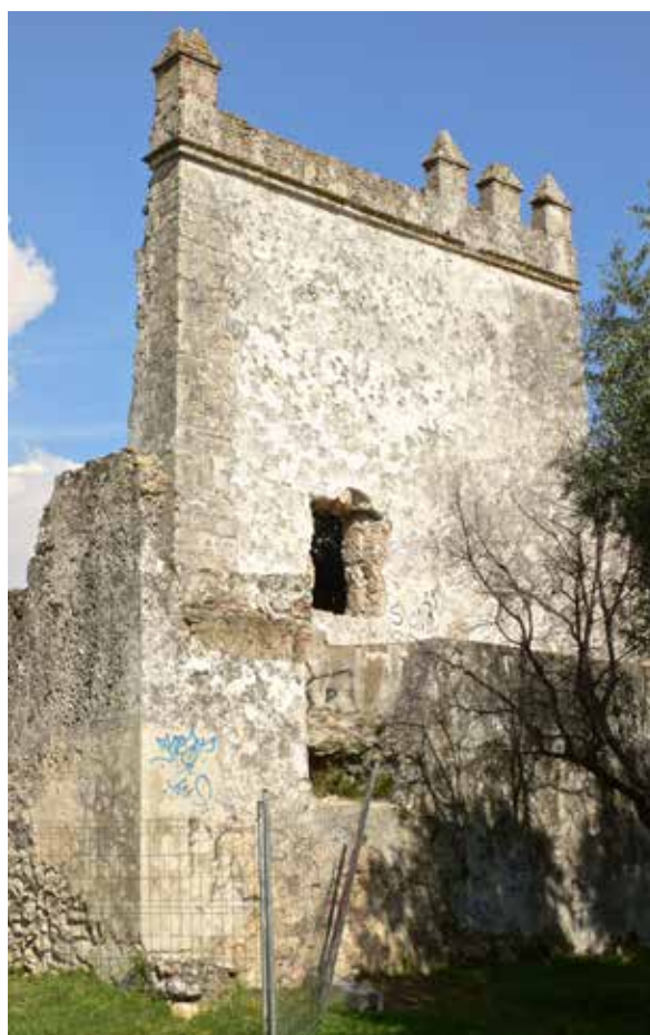
Fig. 36 - Ruínas da torre sudoeste (2012, fotografia da autora)
