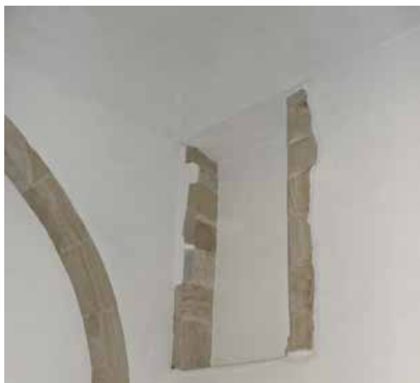
Fig. 94 - Vestígios de uma porta na zona sul da Sala Grande (2012, fotografia da autora)
