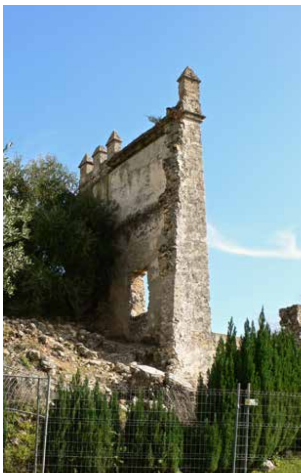
Fig. 35 - Ruínas da torre sudoeste (2012, fotografia da autora)
