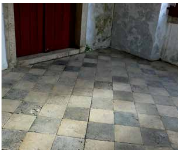
Fig. 155 - Pavimento do alpendre de entrada para o piso superior (2012, fotografia da autora)
