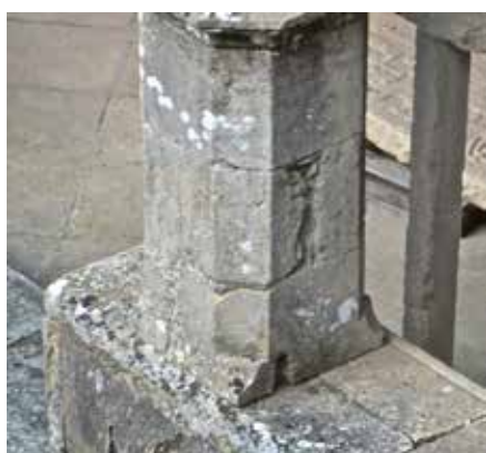
Fig. 83 - Clausto da Lavagem, Convento de Cristo (2012, fotografia da autora)
