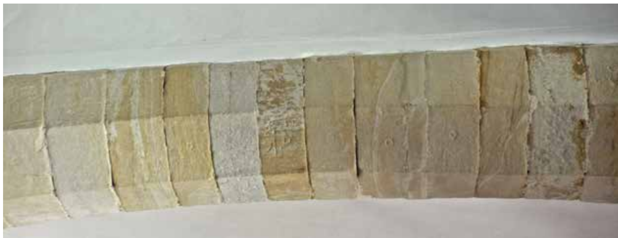
Fig. 93 - Marcas de colocação e siglas de canteiro (2013, fotografia da autora)
