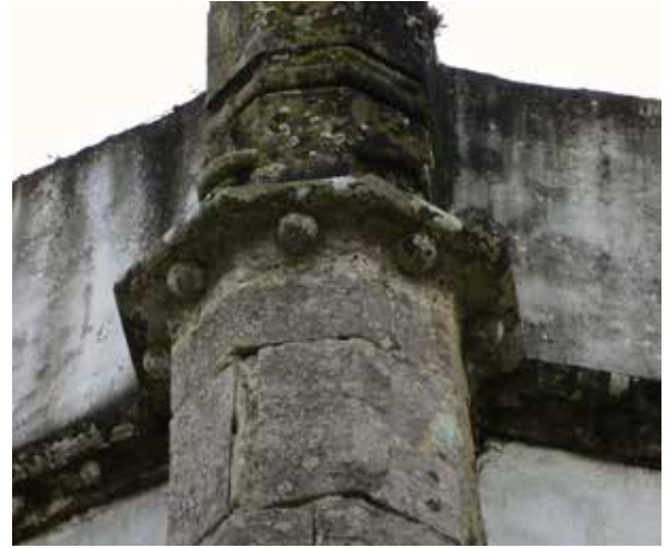
Fig. 175 - Detalhe do contraforte da capela (2013, fotografia da autora)
