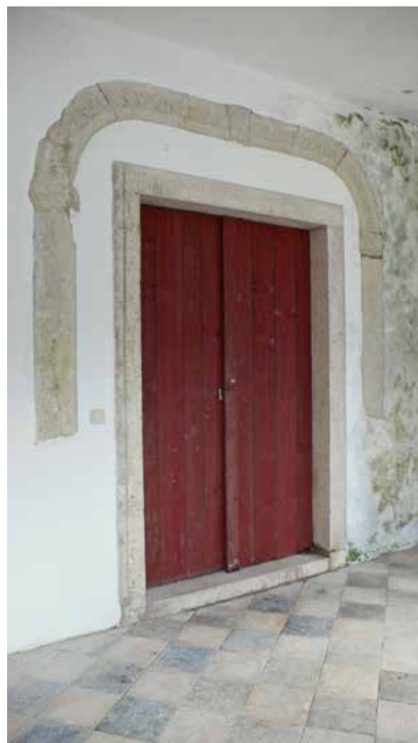
Fig. 157 - Porta de entrada no piso superior (2012, fotografia da autora)
