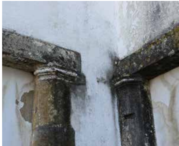
Fig. 246 - Detalhe dos capitéis das portas de serviço (2012, fotografia da autora)
