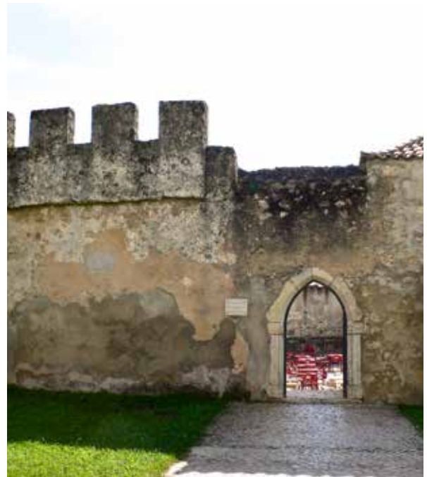
Fig. 17 - Troços do muro norte junto da porta norte (2012, fotografia da autora)
