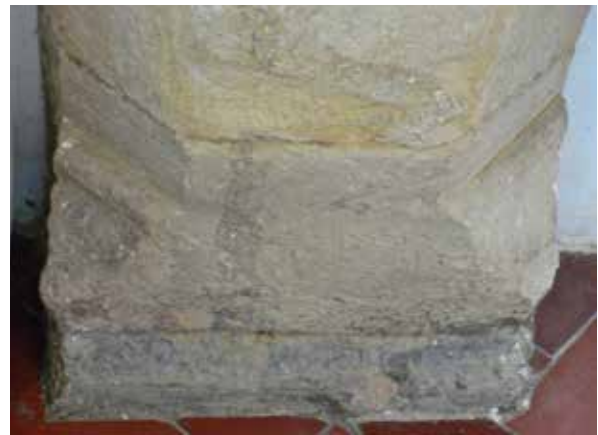
Fig. 92 - Detalhe do pé direito de um arco chanfrado (2012, fotografia da autora)
