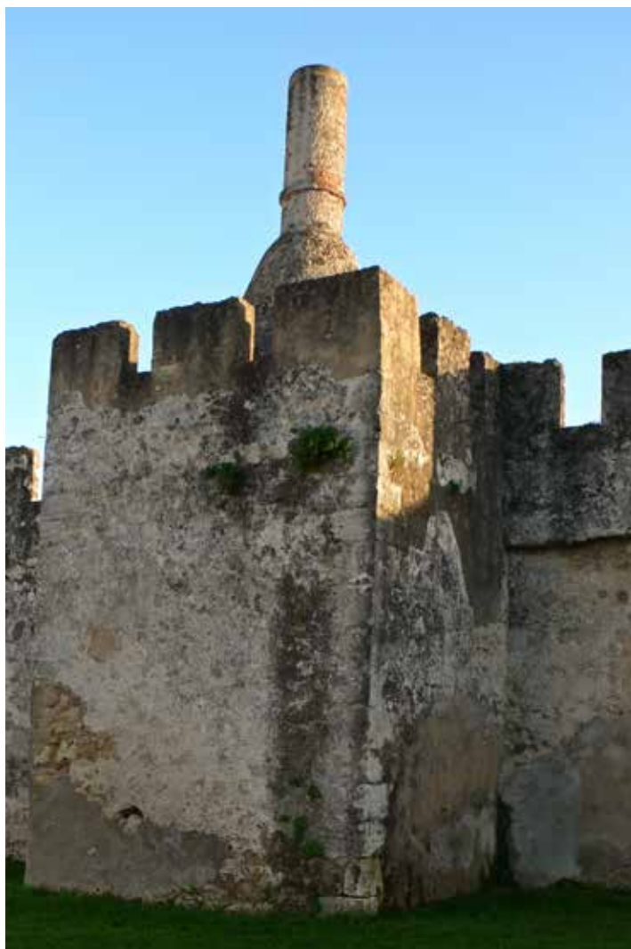
Fig. 24 - Chaminé cónica vista do exterior (2012, fotografia da autora)
