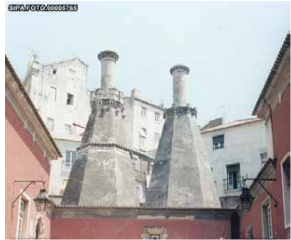
Fig. 30 - Chaminés do Palácio da Independência (fonte: SIPA)
