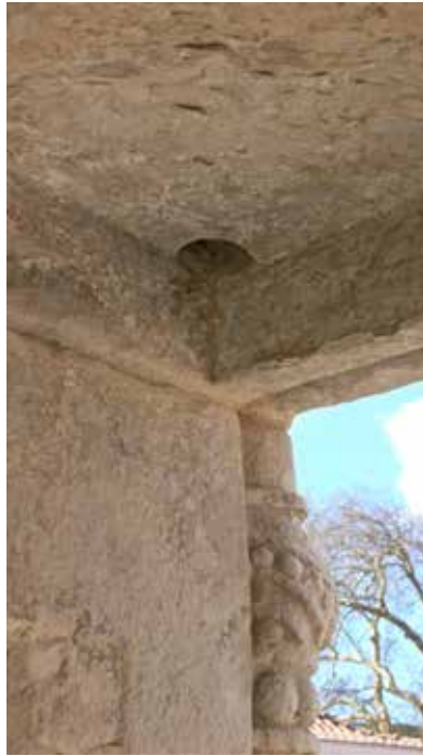
Figs. 113 - Orifício dos gonzos de portadas (2013, fotografia da autora)
