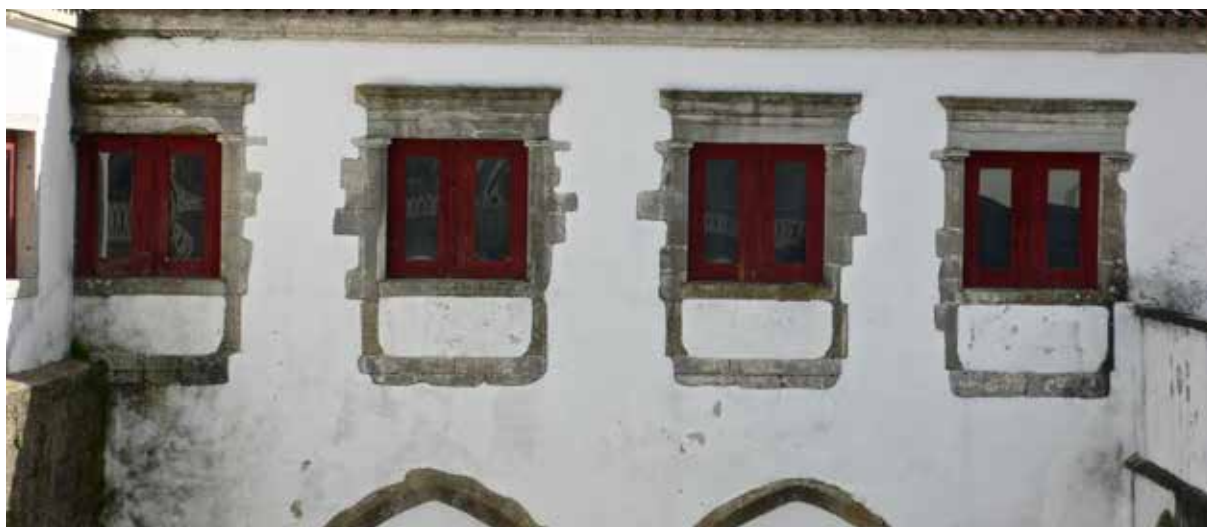
Fig. 159 - Janelas do piso superior da fachada poente (2013, fotografia da autora)
