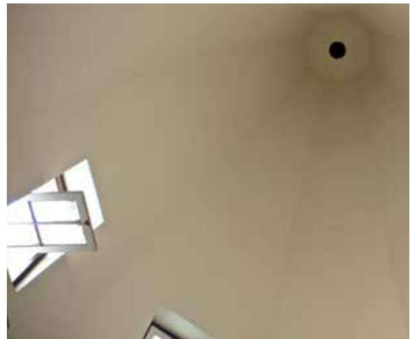
Fig. 31 - Interior de uma das chaminés do Palácio da Independência (2012, fotografia da autora)
