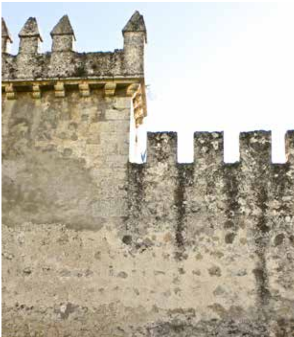
Fig. 16 - Ligação da Torre nordeste com o muro norte (2012, fotografia da autora)
