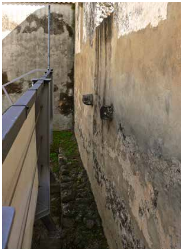
Fig. 48 - Detalhe parede sul do paço (2012, fotografia da autora)
