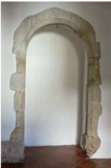
Fig. 150 - Porta emparedada de ligação da galeria à Sala Abobadada (2012, fotografia da autora)
