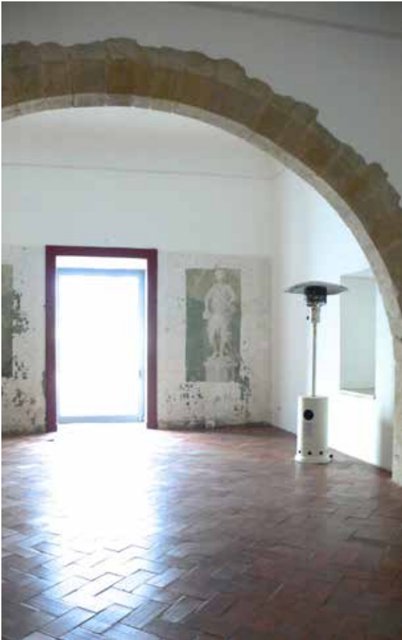
Fig. 88 - Arco chanfrado da Sala dos Frescos (2012, fotografia da autora)
