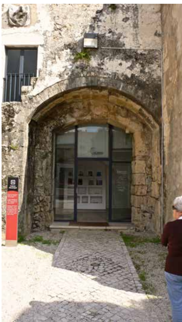
Fig. 42 - Porta da torre nascente de ligação ao pátio (2012, fotografia da autora)
