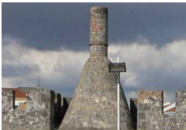
Fig. 23 - Chaminé cónica vista do pátio (2012, fotografia da autora)
