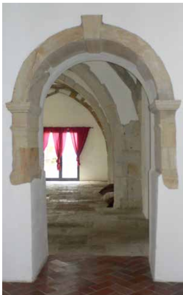
Fig. 197 - Nicho de volta perfeita (2012, fotografia da autora)
