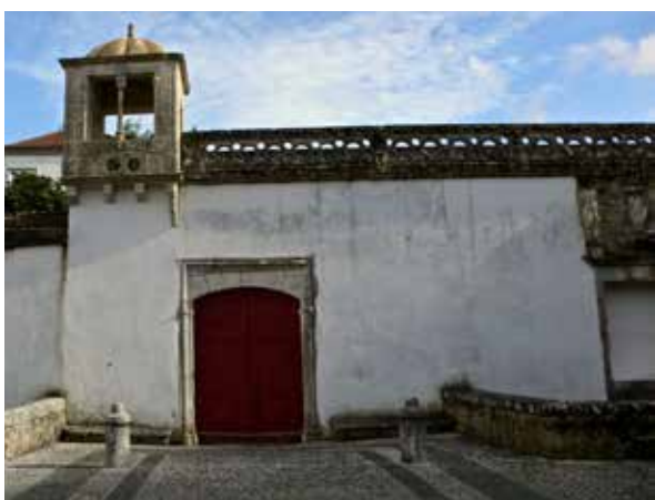
Fig. 123 - Balastrada no muro principal do paço (2012, fotografia da autora)
