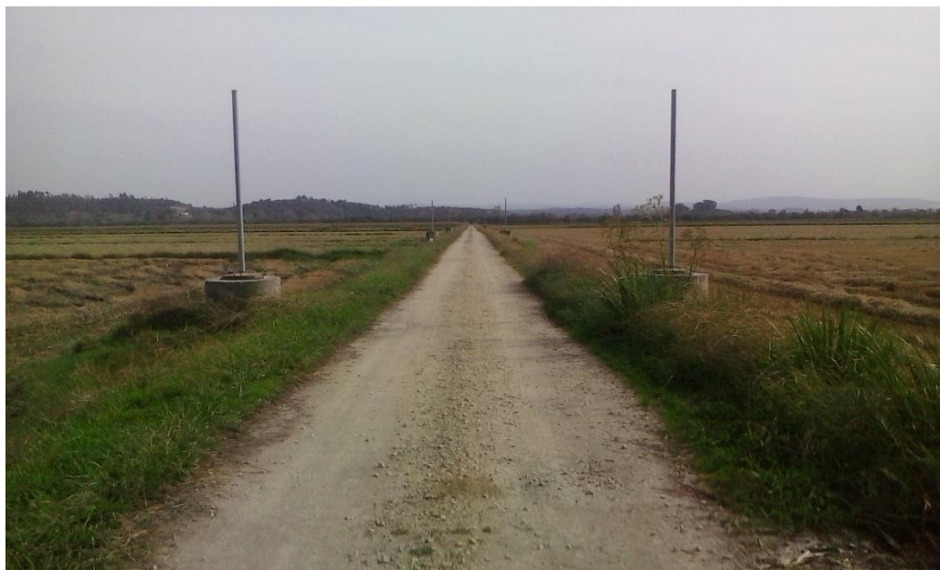
Figura 6: Bocas de rega ao longo do caminho de acesso aos campos agrícolas.
