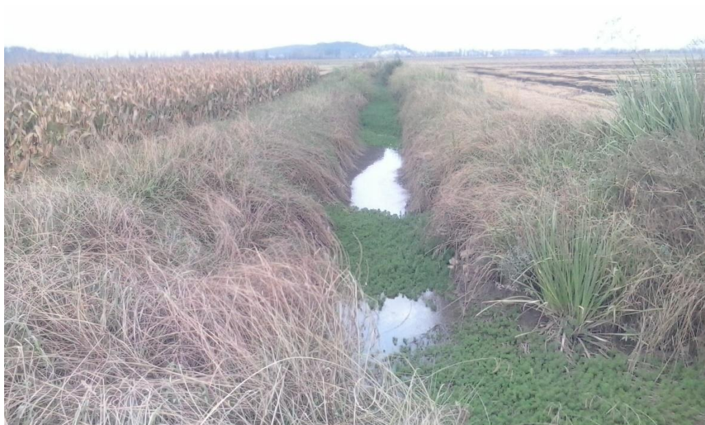
Figura 7: Vala de drenagem.
