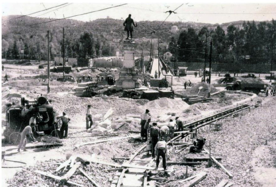
Fig. 12. Colocação dos Carris em 1910 no Largo da Portagem.
