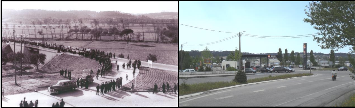
Figura 23 Vista sobre ponto de contacto com o exterior, saída norte.
