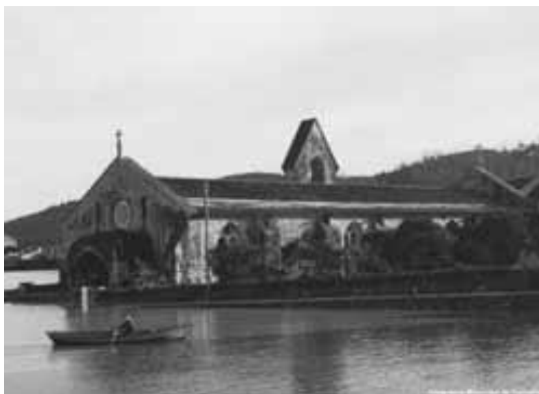
Fig.2- Mosteiro ao Abandono – Inundação.
