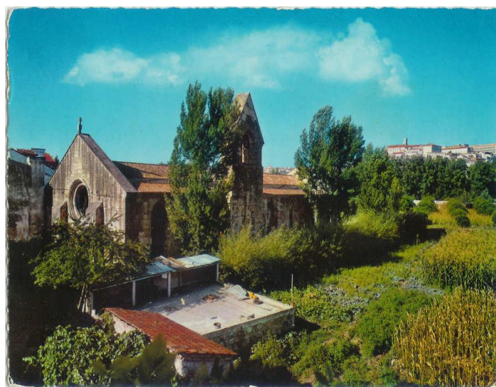
Fig.7 - Postal – Mosteiro de Santa Clara-a-Velha degradado. Fonte: foto tirada por mim a 10 de maio de 2013.
