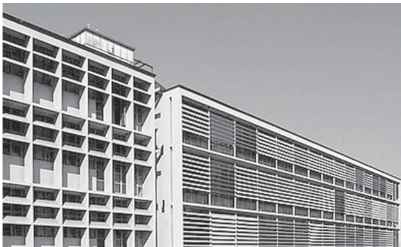
As três primeiras ampliações do edifício industrial da Olivetti.
