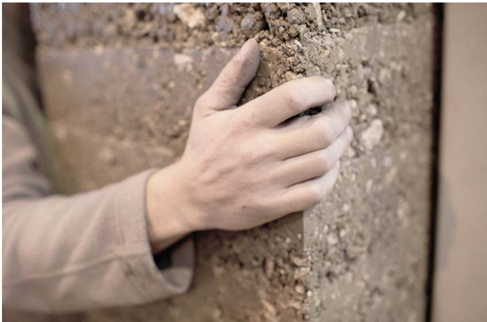
Imagem produzida em computador da nova casa das plantas para a Ricola e fotografia de uma parede-protótipo, feita com os blocos de argila local.
