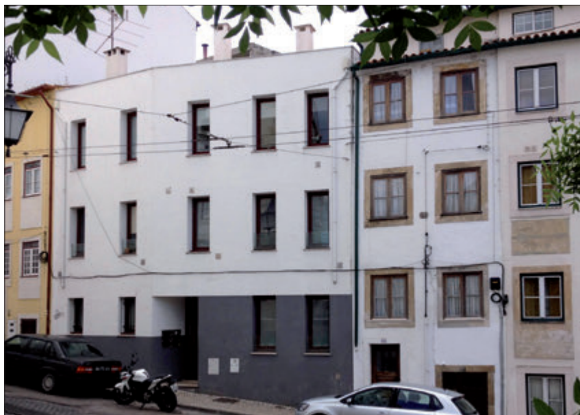
Fig. 8 Rotura do sistema proporcional-compositivo de um dos lados da Rua Padre António Vieira (Coimbra).
