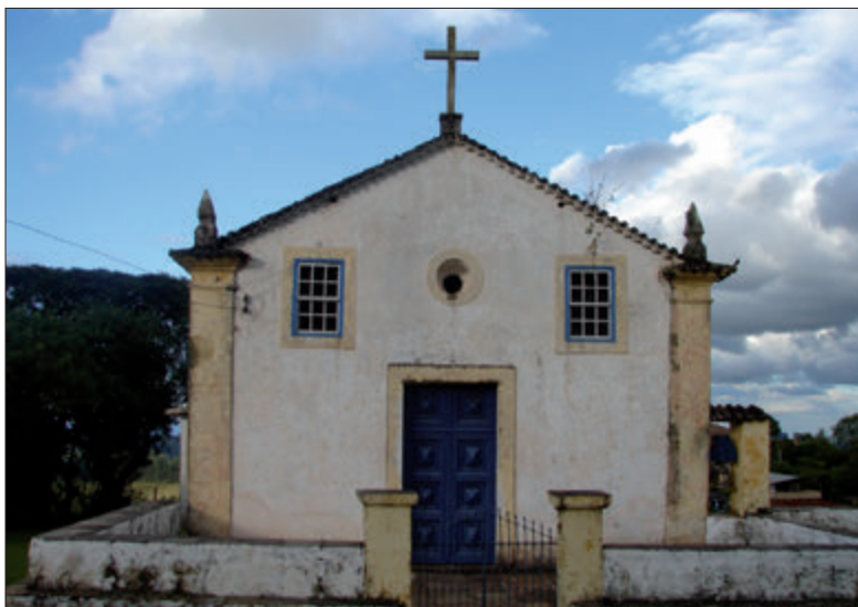
Fig. 6 Capela de São João Batista, Ouro Preto, Minas Gerais, 2012.
