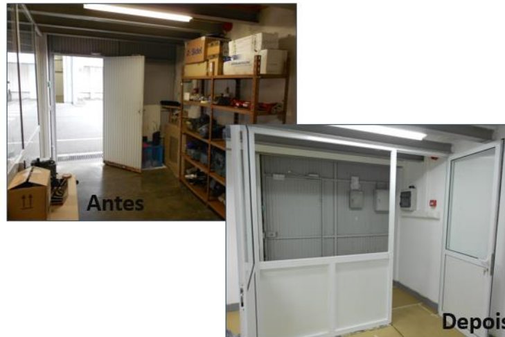
Figura 4.15 - Antes e depois da entrada do armazém.
