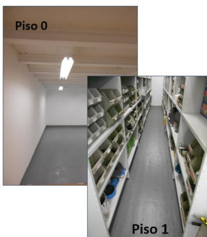
Figura 4.7 – Obras realizadas no Piso 0 e Piso 1
