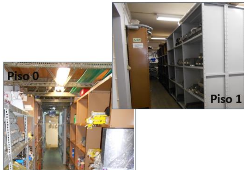
Figura 4.8 - Disposição da iluminação antes.
