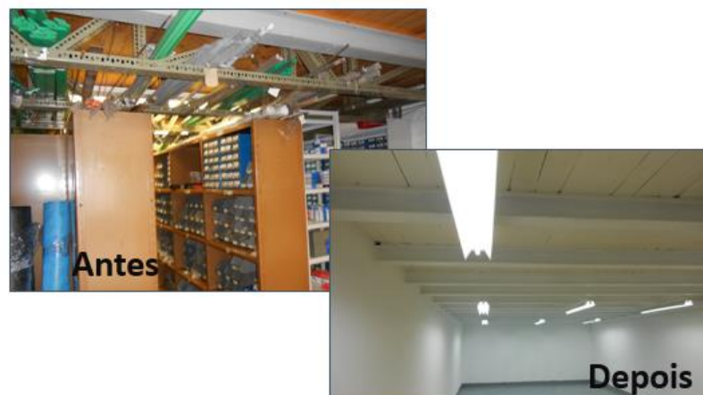
Figura 4.11 - Substituição da estrutura.
