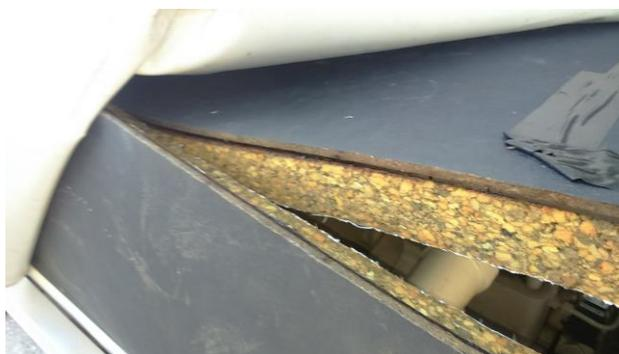
Figura 4-9. Placas de isolamento sonoro do *chiller*.
