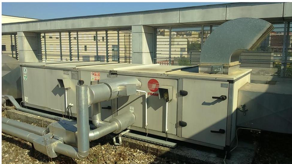
Figura 3-6. Unidade de tratamento de ar da sala de utilizadores de informática, UTASUI.
