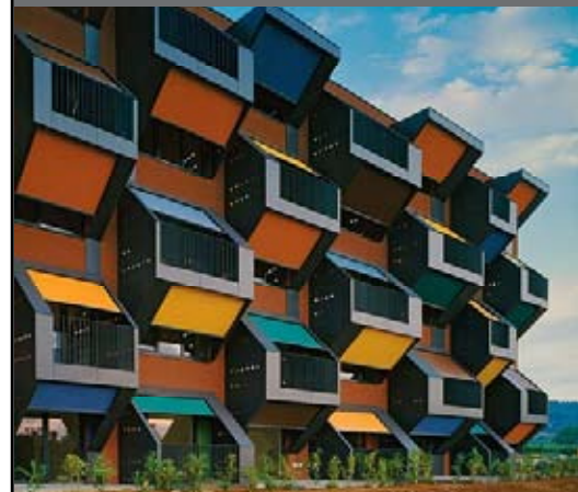
Fig. 89 - Bloco habitacional social; Baía de Izola - Eslovénia
