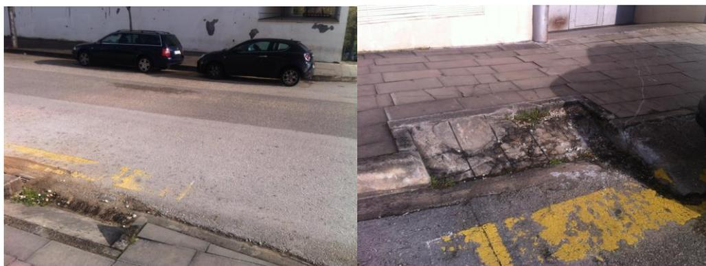
Fotografia 4.2 – Marcação das travessias pedonais e rampeados inclinados e degradados
