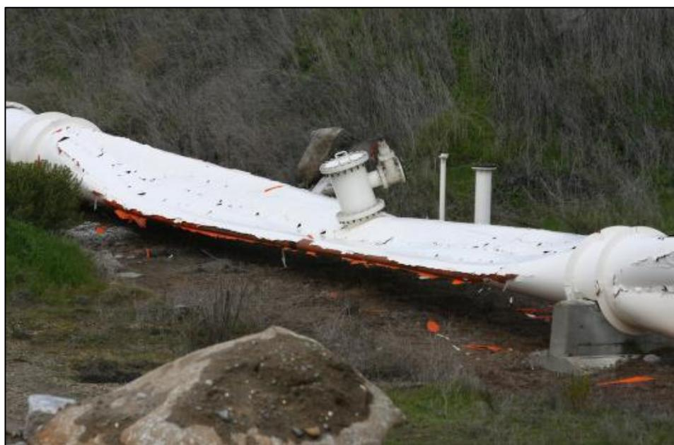
Figura 1.2 – Pormenor de um troço da conduta após o colapso (The Folsom Telegraph, 2009)
