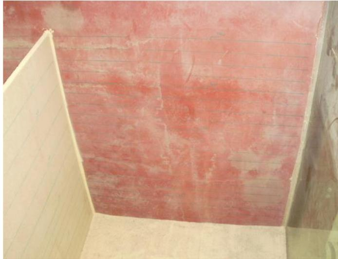
Figura 4.1 – Placa divisória do tanque com marcações para o controlo da altura.
