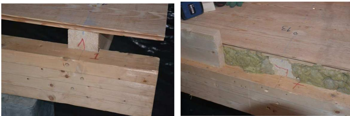
Figura 5.7 - Preenchimento do vazio entre o soalho e as vigas de bordo
