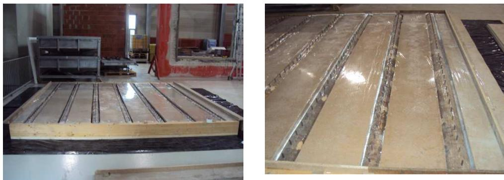
Figura 4.7- Esquema de cofragem da laje LOGCork
