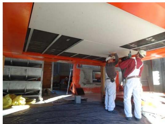
Figura 5.9 - Processo de montagem do tecto falso em gesso cartonado
