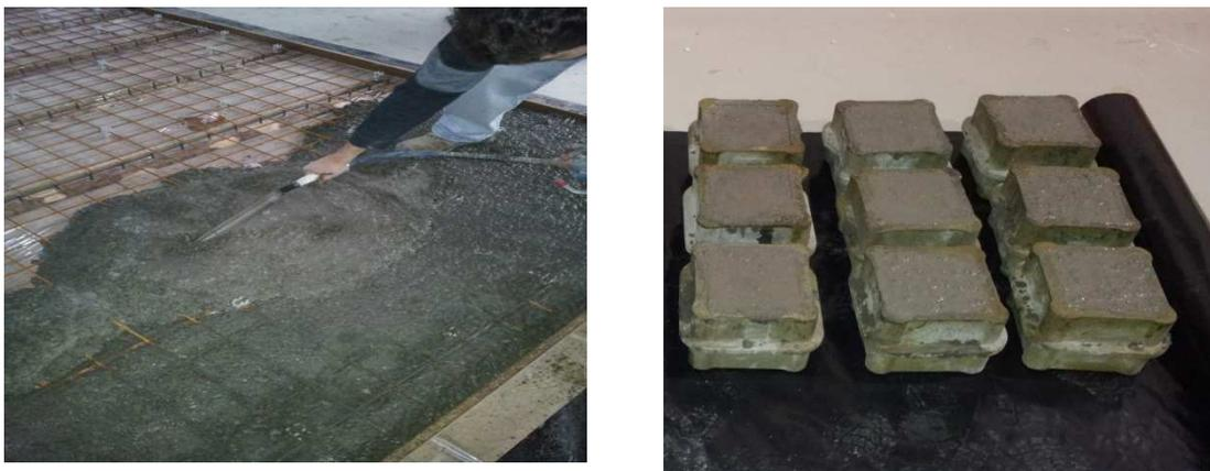
Figura 4.9 - Betonagem da laje LOGCork (à esquerda aplicação do betão; à direita provetes cúbicos)
