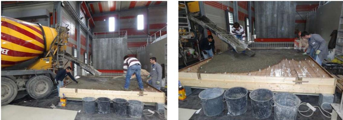
Figura 4.10 – Betonagem do pavimento com vigas de lamelado colado
