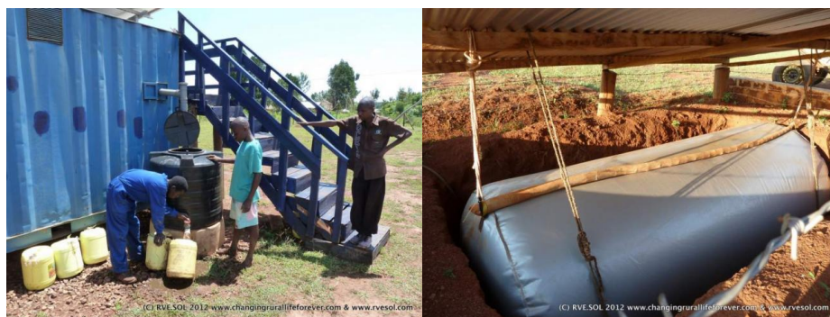
Figura 4.7- Biodigestor (à esquerda) e local de armazenamento do biogás (à direita) (RVE.SOL, 2013a)
