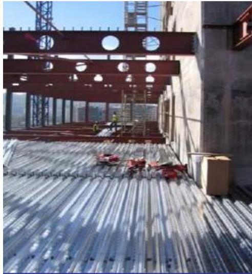
Figura 1 – Exemplo de laje mista (laje nervurada)
