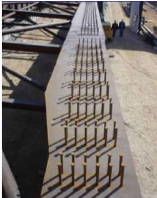
Figura 2 – Viga mista (conectores)
