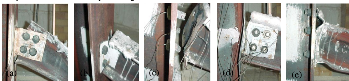
Figura 2.3 - Deformação das ligações: (a) "Fin-plate"; (b) Chapa de topo flexível; (c) Chapa de topo; (d) Web cleat e (e) Chapa de topo estendida (Dai et al. 2009).
