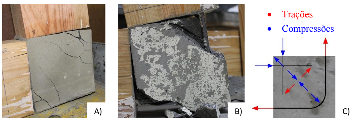
Figura 6.4 - Fendilhação profunda do nó de betão armado na rotura: A-B diferentes planos; C) Modelo simplificado (Negrão et al. , 2014)
