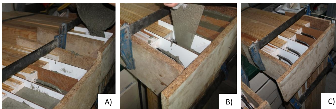
Figura 5.14 - Betonagem dos provetes: A) Nós prontos a serem betonados; B) Processo de vibração do betão; C) Grupos de 5 provetes
