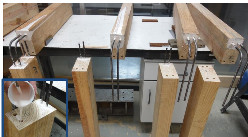
Figura 5.13 - Processo de colagem dos varões de aço
