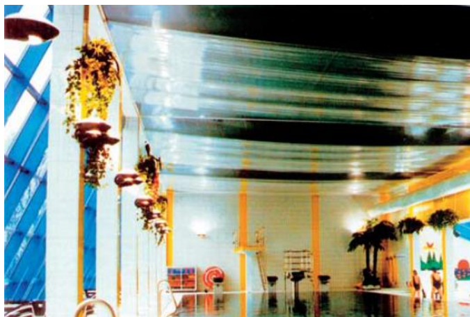
Figura 2.12-Painéis microperfurados com dupla camada de acordo com a Figura 2.11, instalados de baixo do teto de betão de um centro desportivo em Altenkirchen (Helmut e Xueqin, 2006).
