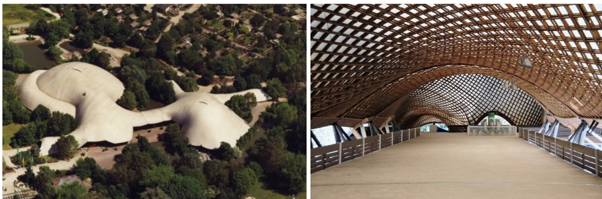
Figura 3.1 - Vista aérea e vista interior, respetivamente, da Multihalle , em Mannheim na Alemanha
