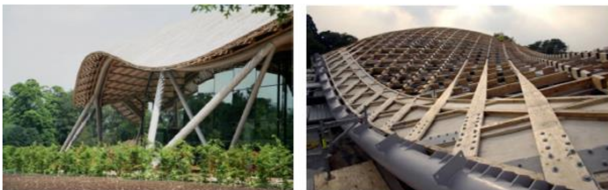
Figura 2.24 – Estrutura de tubos metálicos que suporta a Savill Building Gridshell (Harris et al, 2008)
