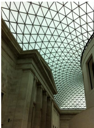
Figura 3.3 – Estrutura de superfície reticulada: Great Court Roof no British Museum , Londres
