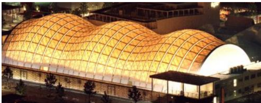
c) Gridshell em tubos de cartão do Japan Pavilion na Expo 2000 em Hannover , Alemanha (imagem da Shigeru Ban Architects )
