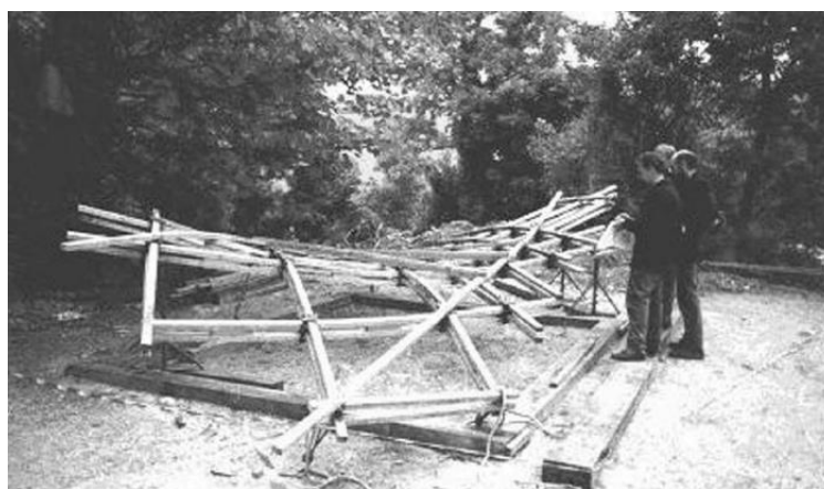
Figura 2.10 - Protótipo construído durante o projeto da Downland Gridshell para testar o comportamento da madeira (Harris et al, 2003)
