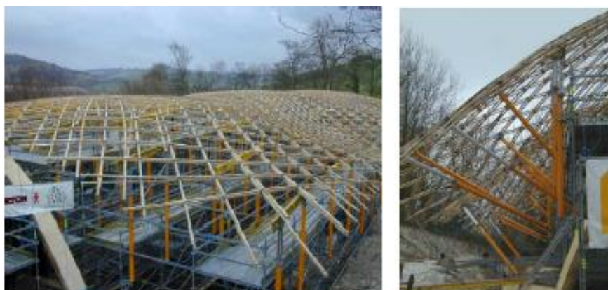
Figura 2.14 - Processo de construção descendente utilizado na Downland Gridshell (Toussaint, 2007)
