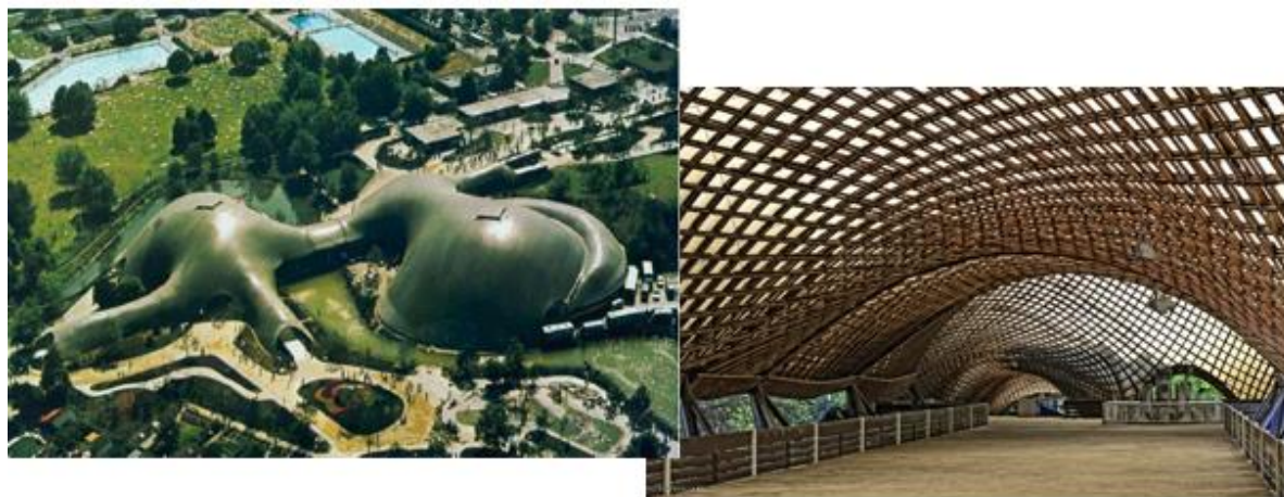
Figura 2.4 – Mannheim Multihalle Gridshell ; Esquerda: Vista aérea (Bouhaya, 2010); Direita: Vista interior (E-kultura@, 2015)
