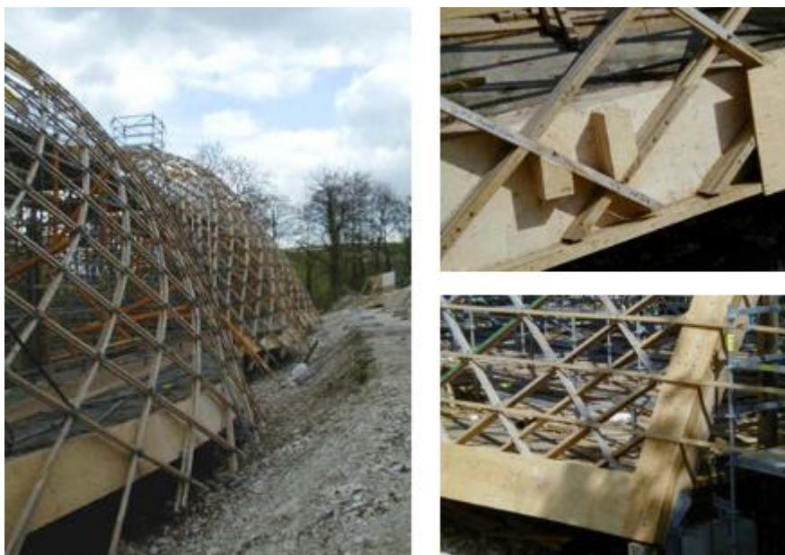
Figura 2.22 - Exemplos demonstrativos das condições de fronteira da Downland Gridshell : Placas de contraplacado na base (Weald&DownlandMuseum@)
