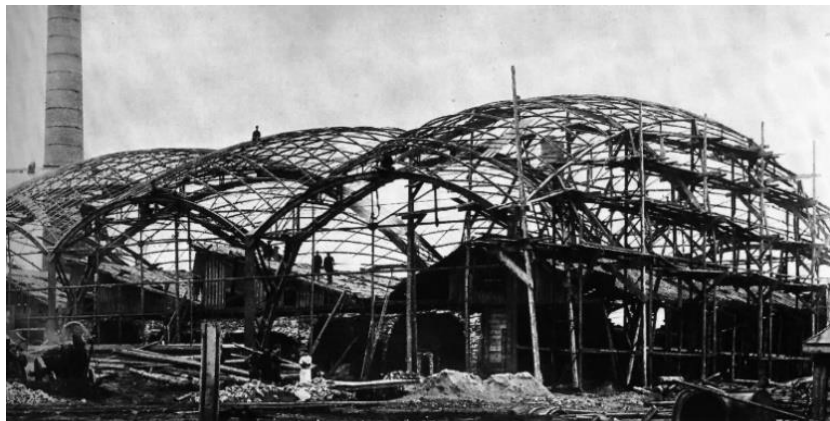
Figura 2.3 - Primeira gridshell em fase de construção no ano de 1897 (Bouhaya, 2010)
