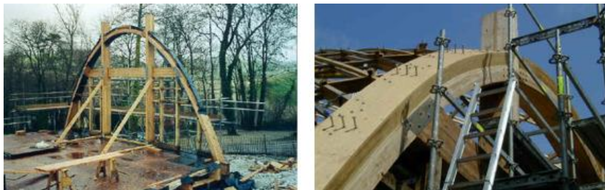
Figura 2.23 – Exemplos demonstrativos das condições de fronteira da Downland Gridshell : Arcos de madeira nas extremidades (Weald&DownlandMuseum@)
