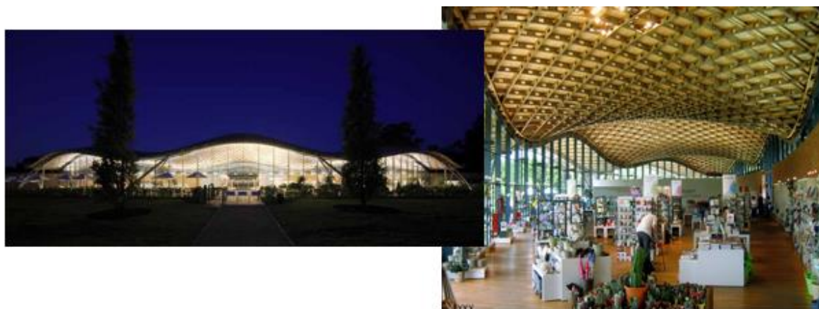
Figura 2.8 - Savill Building Gridshell ; Esquerda: Vista exterior (Foto de Gareth Ggardner); Direita: Vista interior (AtelierTen@, 2007)
