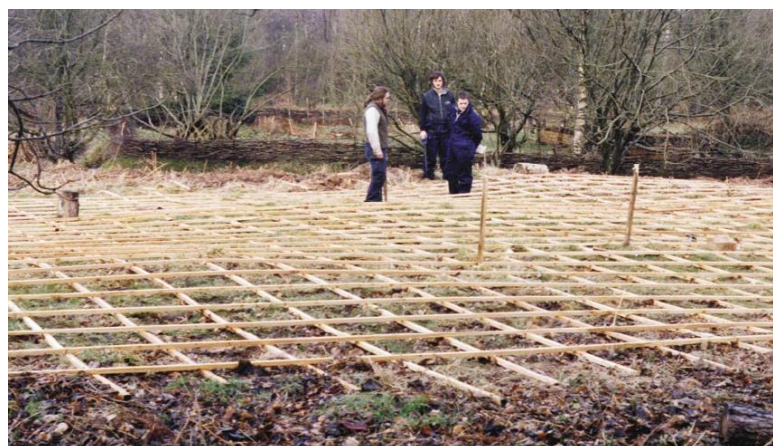
Figura 2.12 – Exemplo prático do início da montagem de uma gridshell em madeira (Buildingforafuture@)
