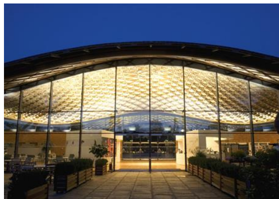
b) Gridshell em madeira do Savill Building em Surrey , Reino Unido (AtelierTen@, 2007)
