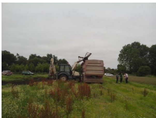
Figura 4.9 – Remoção de lamas para posterior transporte
