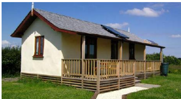
Figura 2.1 – Exemplo de uma construção feita a partir de fardos de palha de trigo, Straw Bale Cabin , situado em Yorkshire, Reino Unido [58].
