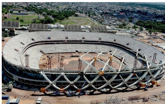
a) Fase de Construção. Fonte: Chico Batata
