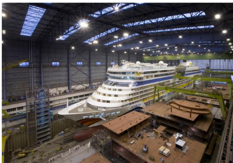
Figura 3.7 - Pórtico treliçado Meyer Werft - Estaleiro para construção de navios - Papenburg, Alemanha
