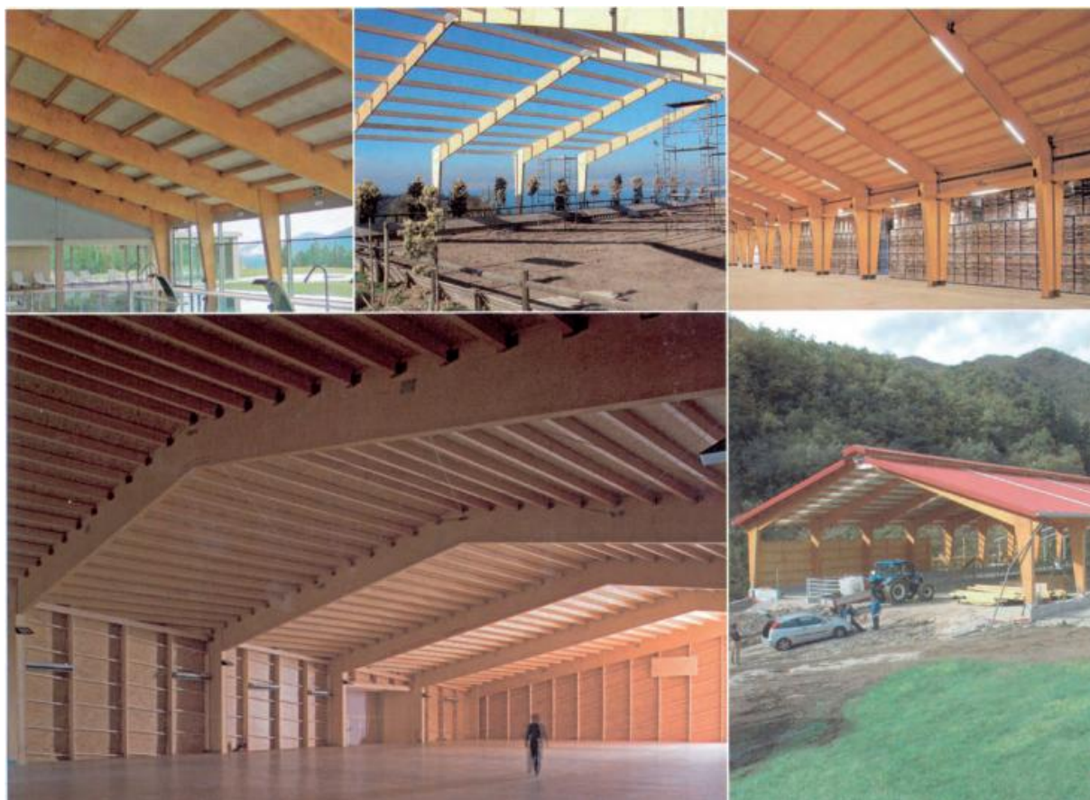
Figura 2.5 - Pórticos Kerto em madeira. Fonte: JULAR madeiras
