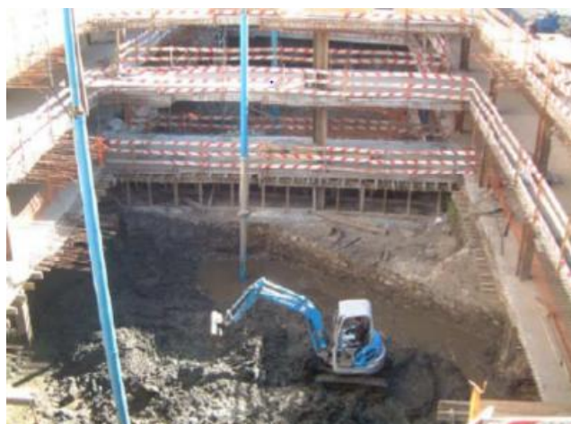
Figura 2.7 - Contenção em top-down , através de bandas de laje para execução de 5 caves num edifício na baixa de Coimbra (Costa et al, 2010).
