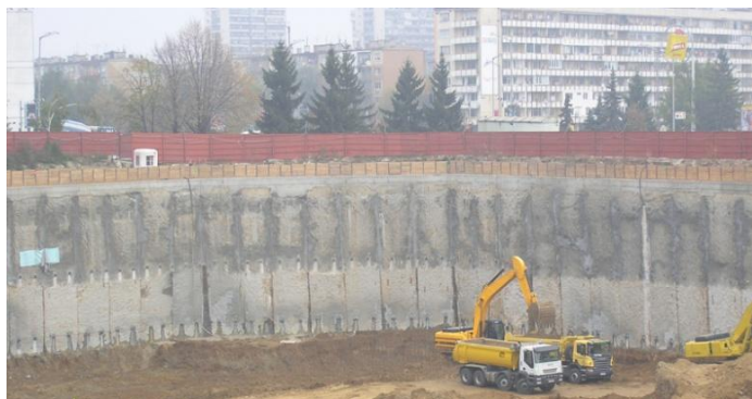
Figura 2.1 - Obra executada com Paredes Moldadas (BAGTC@, 2015).
