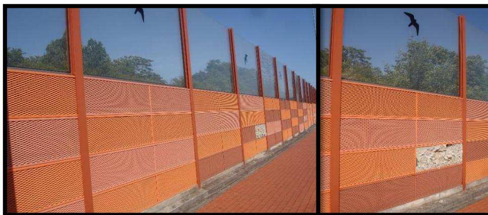
Figura 2.1 - Barreira acústica tradicional visivelmente degradada
