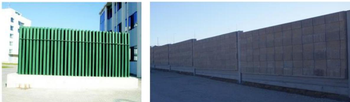
Figura 2.6 – À esquerda uma barreira acústica de cristais sônicos (in Garcia, 2010), à direita uma barreira acústica de betão (in portefólio empresa Jopires)
