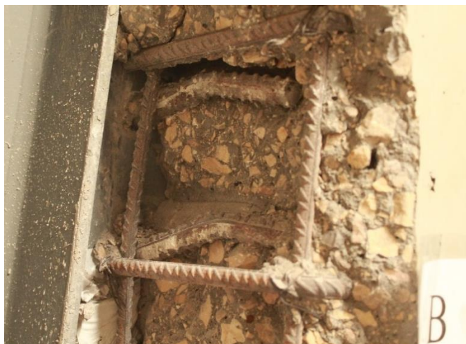
Figura 5.31- Sollicitação da armadura no ensaio 15
