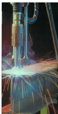
Figura 2.7- Solda por arco elétrico conector stud (NELSONSTUD@, 2015)
