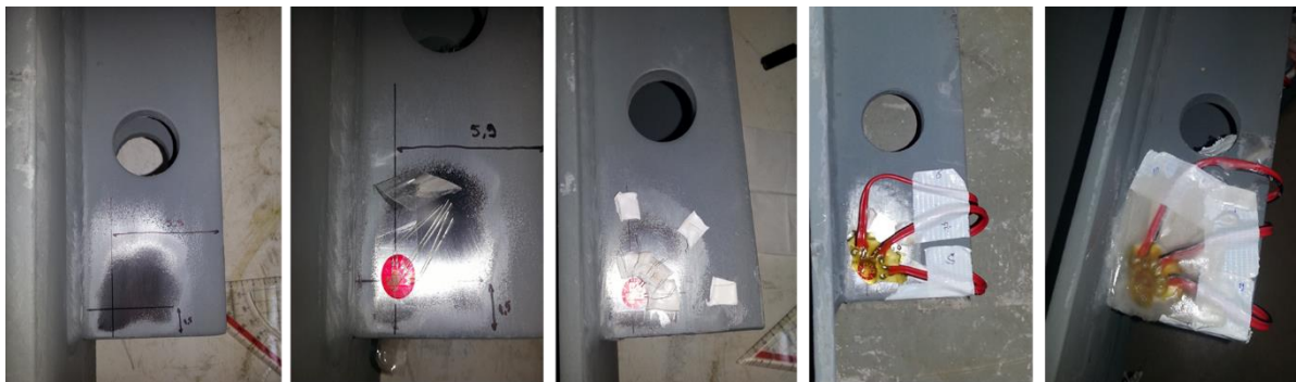
Figura 4.11- Ilustração dos extensómetros de roseta nos conectores, nas várias fases de instrumentação
