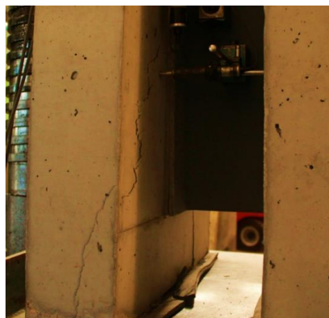
b) Modo de rotura final - Ensaio 10: Laje B
