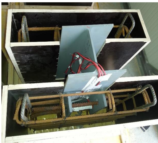
Figura 4.13- Ilustração de um provete na fase pré-betonagem
