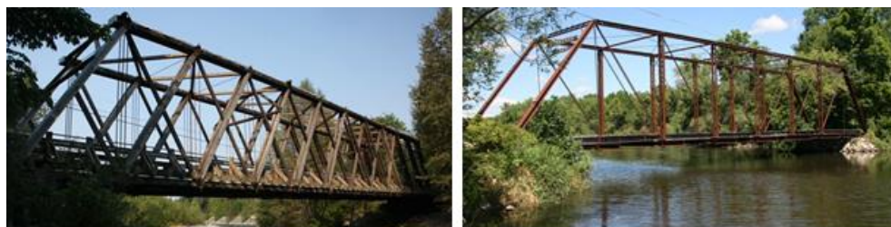
Figura 1.1- Ponte treliçada tipo Howe (Regent Road Bridge) à esquerda e tipo Thomas e Pratt (Bieneman Farm Bridge) à direita (Historicbridges@, 2015)
