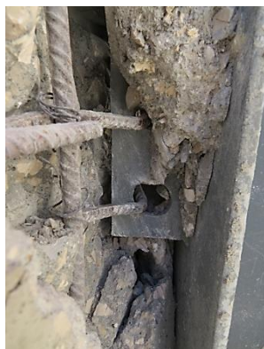
a) Armadura de reforço do conector TPU_AR10_B em betão C20/25 b) Armadura de reforço do conector TPU_AR16_A em betão C20/25
