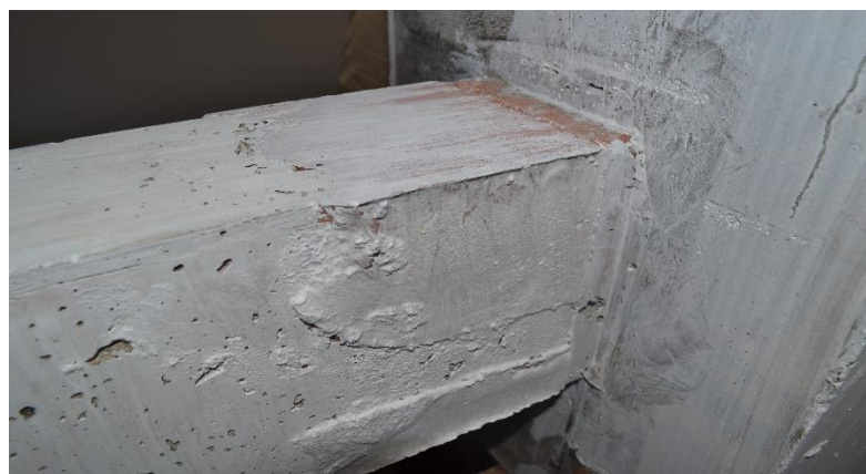
Figura 4.31 - Provete 5 após reparação.
