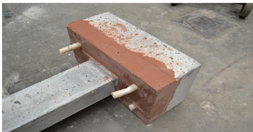
Figura 4.19 - Provete 3 após reparação.
