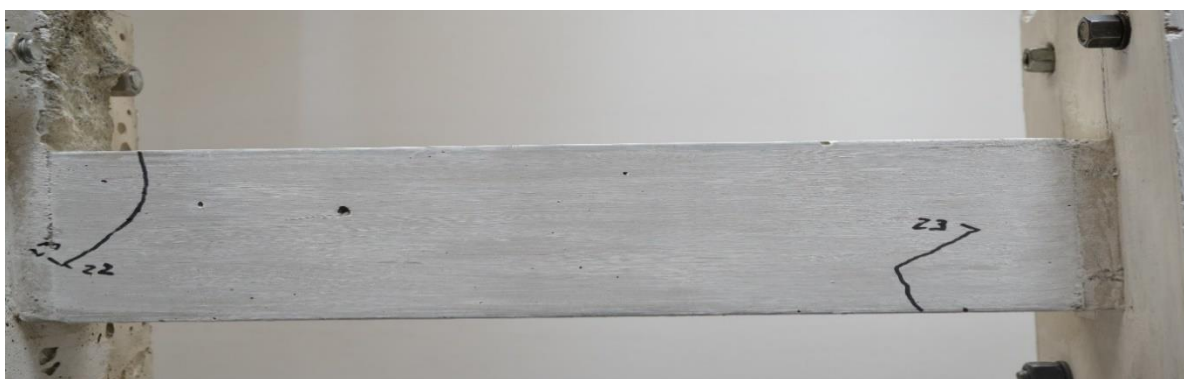
Figura 4. 6 - As duas primeiras fissuras visualizadas no Proвете 1 .
