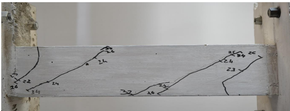
Figura 4. 7 - Desenvolvimento das fissuras do Provete 1 .
