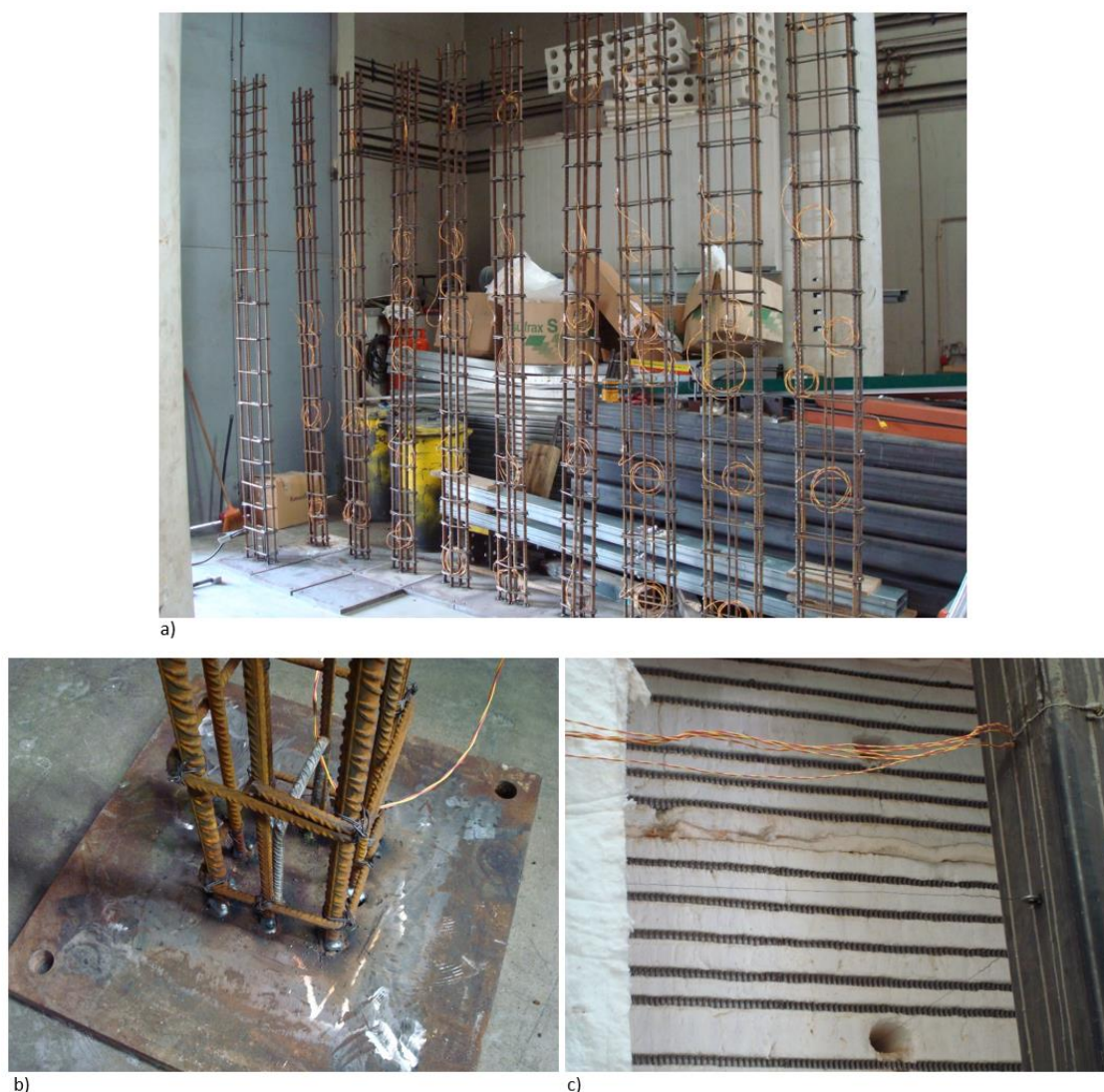
Figura 3.3– Pormenores de instrumentação a) Montagem de armaduras b) Ligação do provete à chapa de topo c) Pormenor de termopares
