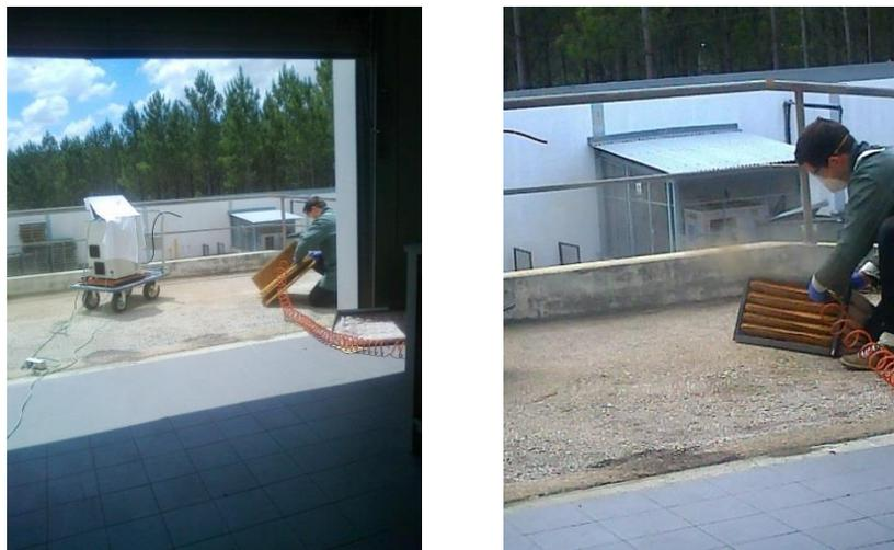
Figura 3.6 – Processo de limpeza dos filtros do equipamento de maquinagem por laser.
