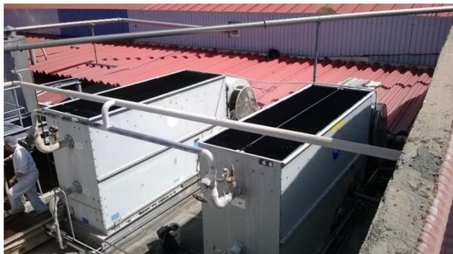
Figura 45. Torres de arrefecimento a água
