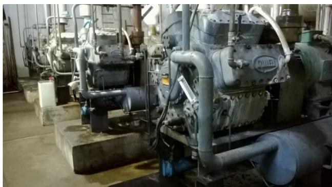
**Figura 43. Compressores de frio do circuito de baixa pressão**
