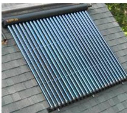
**Figura 2.7. Coletor de tubos de vácuo (SolarPanelPlus, 2014)**
