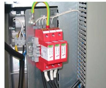
**Figura 4.20 - Descarregadores de sobretensão**
