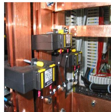
Figura 4.9 -Transformadores de corrente
