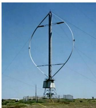
Figura 1.4 - Turbina eólica de eixo vertical - *Darrius*
