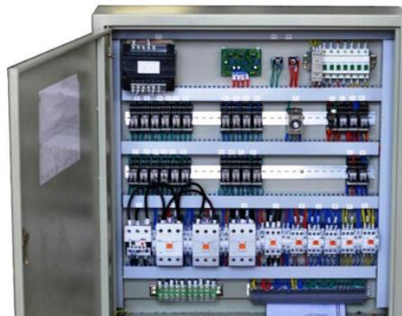
Figura 3.1 – Controlador baseado em relés electromagnéticos [5]
