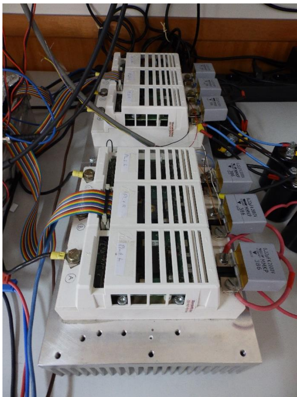
Figura D.1 - Módulos de IGBTs que constituem as 3 pontes H do CM
