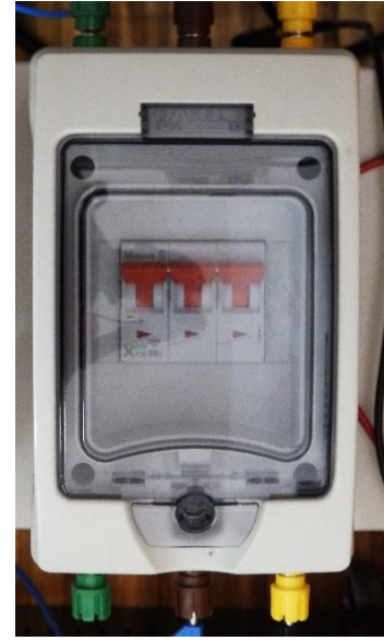
Figura D.20 - Interruptor de saída do CM
