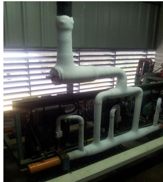
Figura 18 - Formação de gelo na tubagem da empresa C
