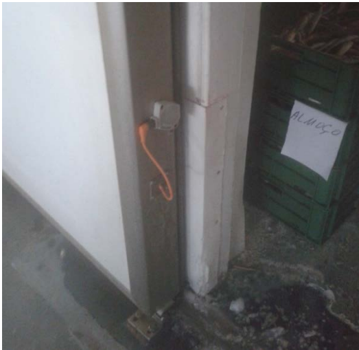
Figura 19 - Reparação feita manualmente numa das câmaras de refrigeração da empresa A
