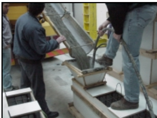
Fotografia 3.3 (a) - Betonagem das sapatas.
