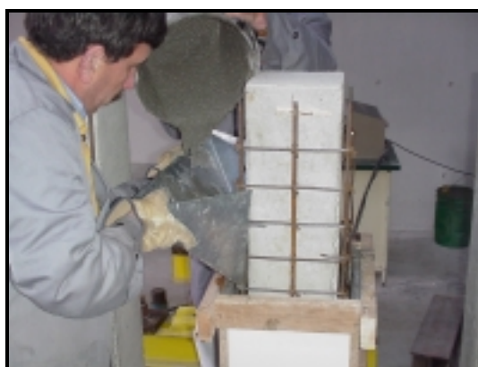
Fotografia 3.5 (d) - Betonagem do terço intermédio do reforço.
