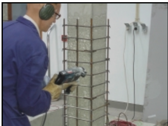
Fotografia 3.15 (a) - Execução dos furos nos modelos.
