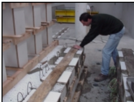
Fotografia 3.3 (b) - Isolamento das janelas das sapatas.
