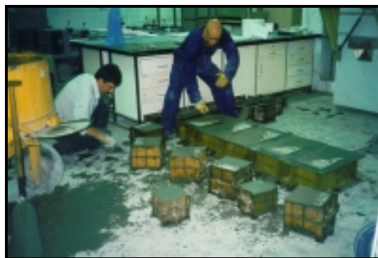
Fotografia 2.3 (b) - Betonagem da segunda metade dos provetes slant shear , pull-off e cúbicos
