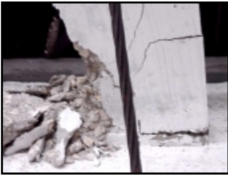
Fotografia 4.3 (a) - Fissuração da zona do encastramento do modelo M1G1.
