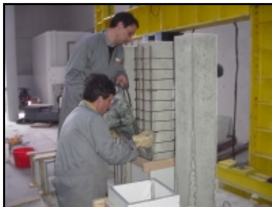
Fotografia 3.5 (b) - Betonagem do terço inferior do reforço.
