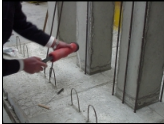
Fotografia 3.4 (a) - Execução dos furos na sapata; Fotografia 3.4 (b) - Limpeza dos furos da sapata.
