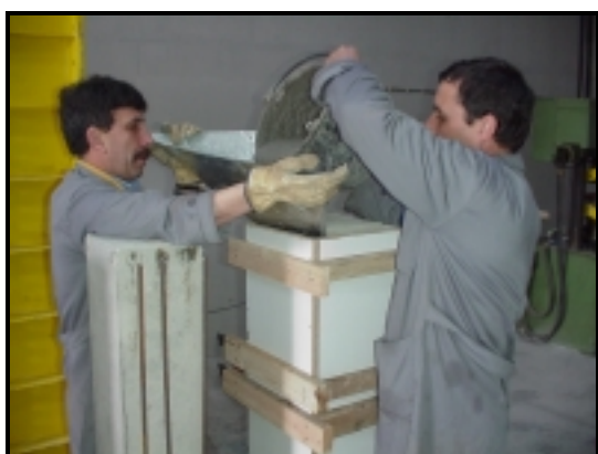
Fotografia 3.5 (e) - Betonagem do terço superior do reforço.
