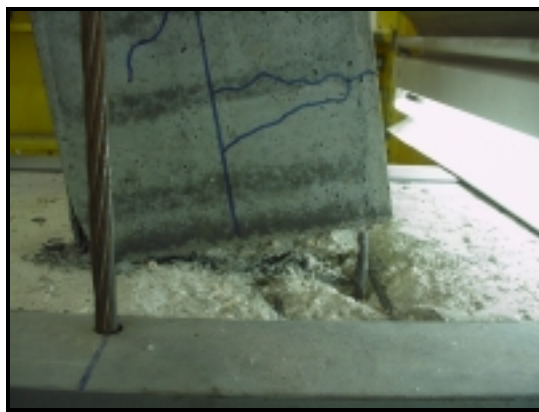
Fotografia 3.8 (b) - Escorregamento dos varões traccionados da armadura longitudinal de reforço.
