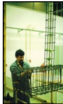
Fotografia 3.2 (b) Montagem das armaduras.
