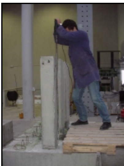
Fotografia 3.13 (a) - Execução dos furos nas sapatas.
