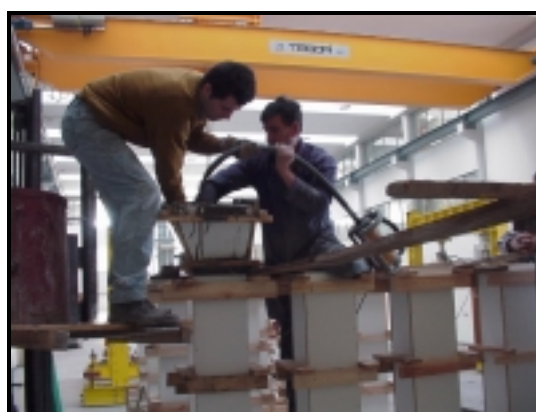
Fotografia 3.3 (c) - Betonagem dos pilares.
