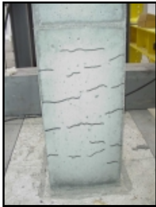
Fotografia 3.10 (a) - Fissuração na face traccionada do modelo.
