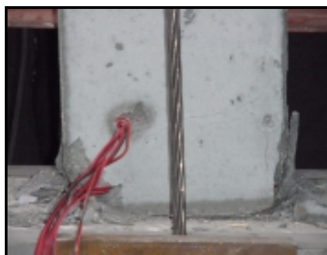
Fotografias 5.2 (g) - Fissuração da zona do encastramento do modelo M2G3.
