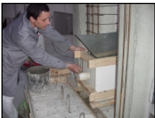
Fotografia 3.5 (c) - Ligeira compactação do betão do reforço.
