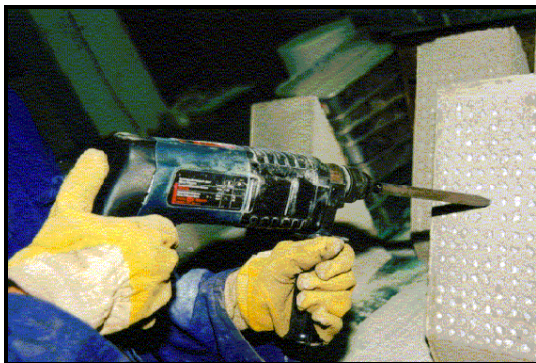
Fotografias 2.2 (b) - Preparação da superfície da interface com martelo eléctrico de baixa potência (picada parcialmente).
