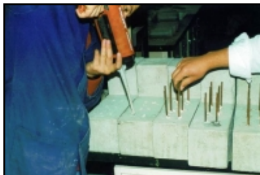
Fotografia 2.11 (d) - Aplicação dos conectores.
