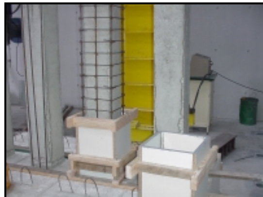
Fotografias 3.4 (f) - Preparação da cofragem de reforço.
