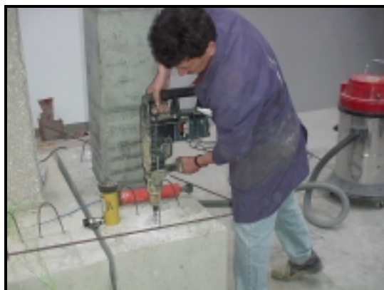
Fotografia 3.12 (a) - Execução dos furos na sapata.
