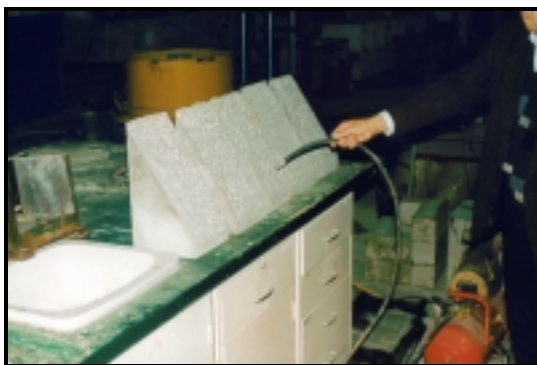
Fotografia 2.3 (a) - Limpeza da superfície da interface com jacto de ar
