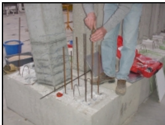
Fotografia 3.12 (d) - Ancoragem dos varões.
