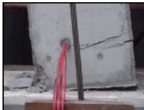
Fotografia 4.3 (g) - Fissuração da zona do encastramento do modelo M1G3.
