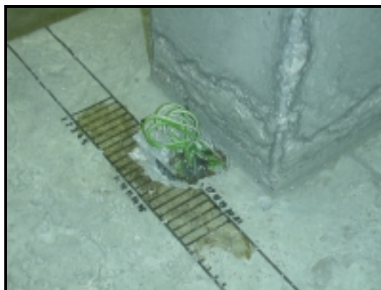
Fotografia 3.13 (e) - Aspecto final dos fios reparados.
