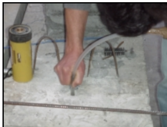
Fotografia 3.12 (b) - Limpeza dos furos com o aspirador.
