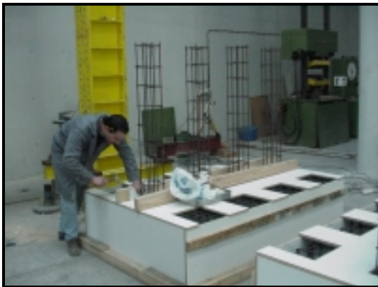
Fotografia 3.2 (c) - Introdução das armaduras nas cofragens das sapatas.
