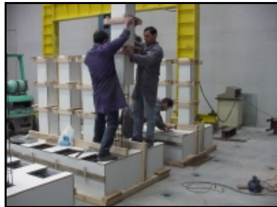
Fotografia 3.2 (d) - Aplicação das cofragens dos pilares.
