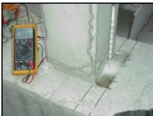
Fotografia 3.13 (c) - Execução dos furos depois de localizada a baínha.
