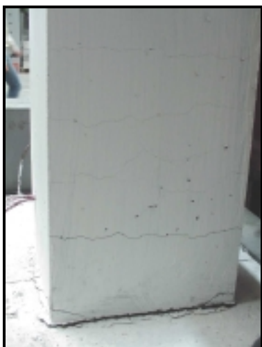
Fotografia 5.1 (e) - Fissuração da face traccionada do modelo M5G2.
