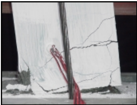
Fotografia 4.3 (e) - Fissuração da zona do encastramento do modelo M5G1.
