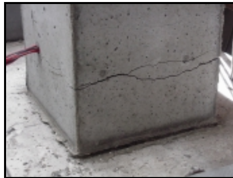
Fotografia 4.3 (f) - Fissuração da zona do encastramento do modelo M6G1.
