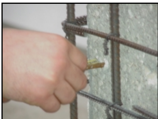
Fotografia 3.15 (c) - Aplicação dos conectores.
