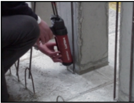
Fotografia 3.4 (c) - Aplicação de Hilti HIT-HY 150; Fotografia 3.4 (d) - Ancoragem dos varões.
