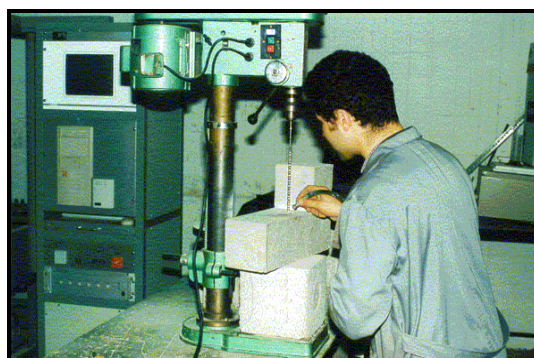
Fotografia 2.11 (b) - Limpeza dos furos com jacto de ar.
