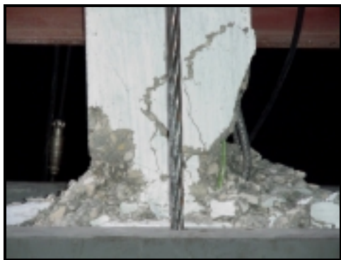
Fotografias 5.2 (a) - Fissuração da zona do encastramento do modelo M1G2.
